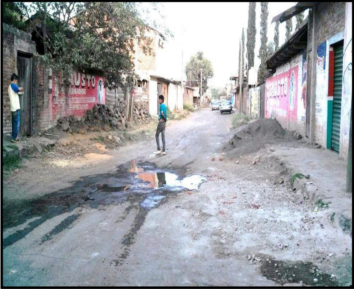
Figura 3.8. En esta imagen se aprecia la diferencia de niveles de terreno natural que es uno de principales problemas a resolver.
