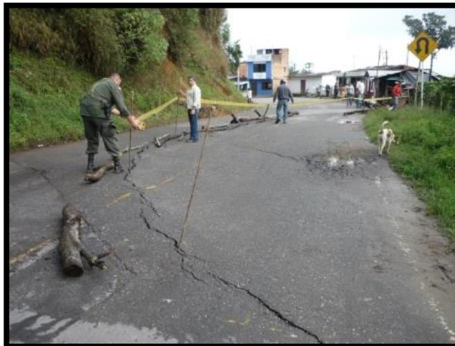
Figura 2.27 Agrietamiento Ocurrido en un pavimento rígido.
