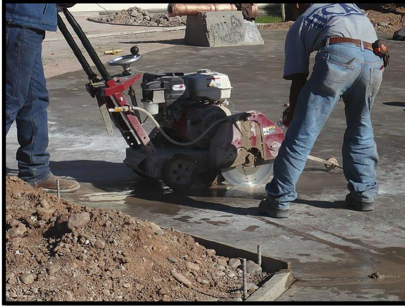
Figura 2.25 Corte con Disco.
