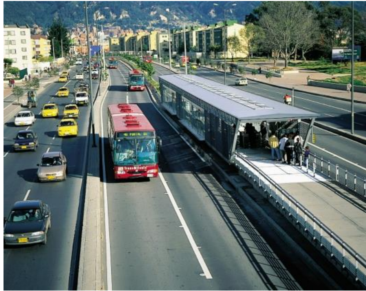
Imagen 2.1 Vía tipo C.
