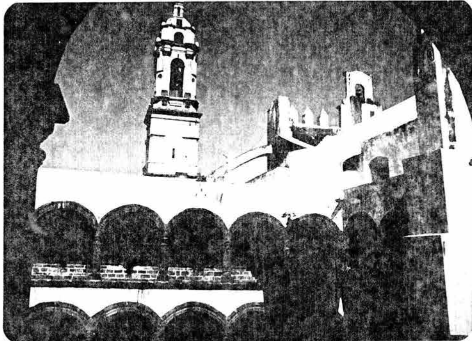
Lámina 38. Vista del claustro del convento con el masivo contrafuerte que sostiene el lado sur de la capilla conventual.
