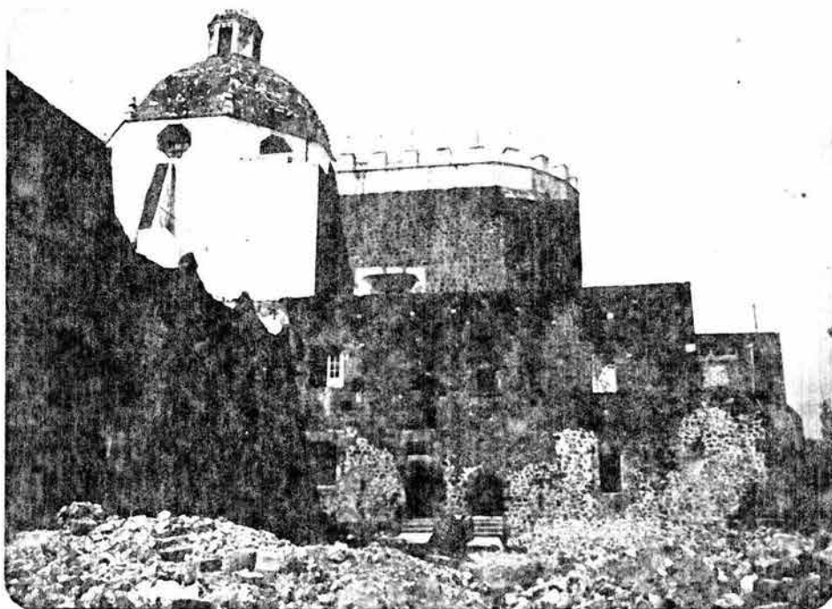
Lámina 35. Una vista del convento con su enorme ábside, desde el lado sureste.
