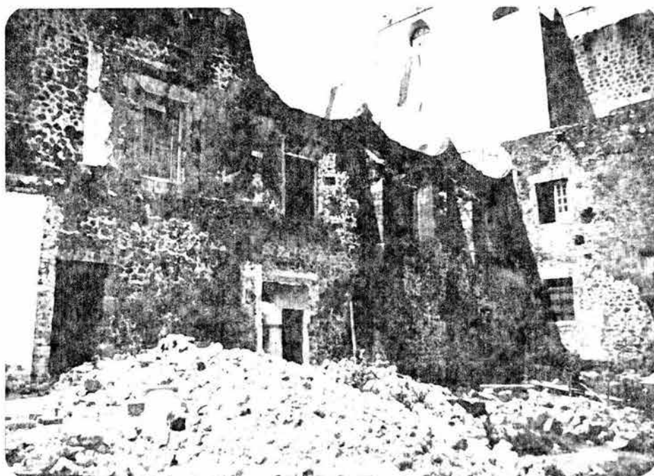
Lámina 36. Detalle del muro este del convento.
