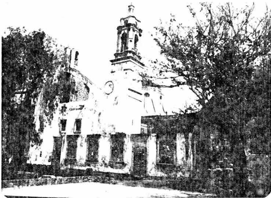
Lámina 29. La fachada poniente del convento con el campanario y restos de las ventanas de las habitaciones conventuales.
