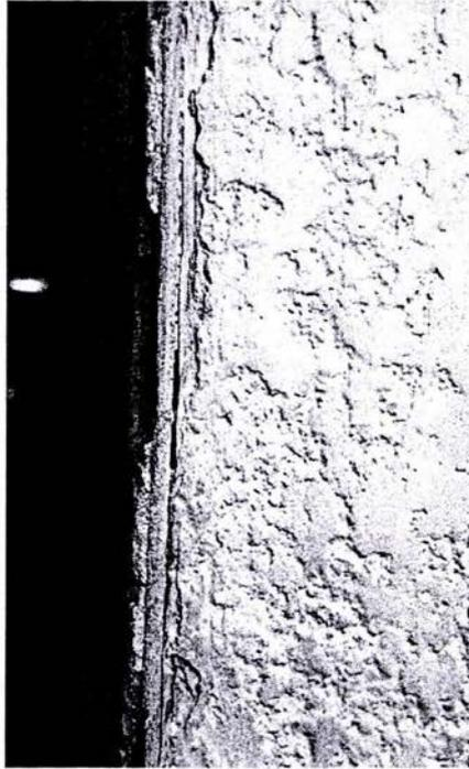
Imagen 61. Aquí podemos ver de izquierda a derecha como están localizadas las diferentes capas de protección empezando por el corcho capa superficial, madera, 5mm de plomo y al final concreto.
