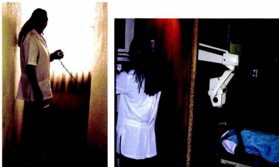
Imagen 58, 59 La protección se logra controlando el aparato de rayos x por medio de un cordón de seguridad, atrás de una barrera o con el tablero de controles situado por detrás de esta.
