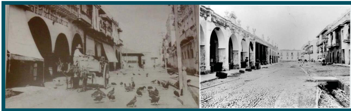
FIGURA 66 PRESENCIA DE NOPOS Y DRENAJE A CIELO ABIERTO
