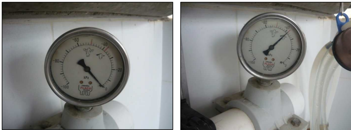
Figura 22. Verificación en el vacuometro de los niveles de vacío en kilopascales (kPa)
