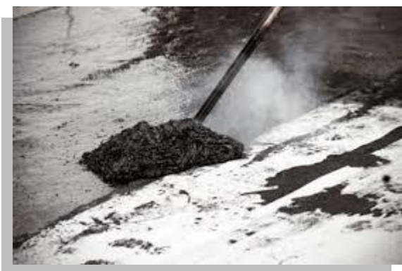
Fig. 30 y 31.-Aplicación del impermeabilizante asfáltico en caliente.
