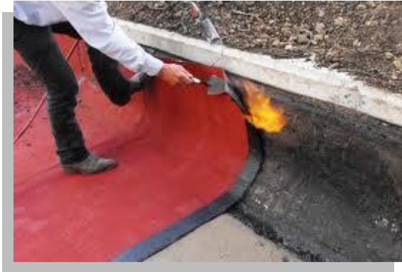
Fig. 34 y 35.- En ocasiones la llama del soplete se pasa por encima del acabado aparente, esto es una mala practica ya que se puede quemar la gravilla que viene adherida ocasionando que se desprenda y así quede expuesta la capa de asfalto..
