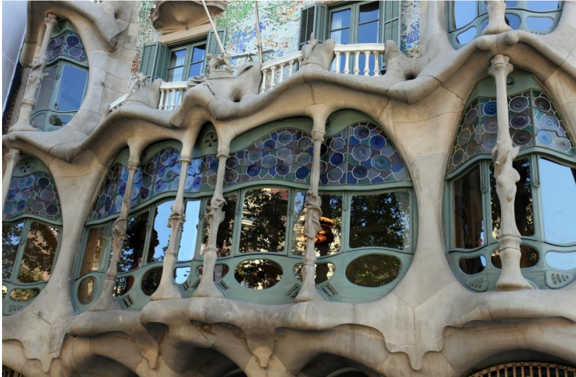
18.- Casa Batlló. Detalle de la fachada principal. Paramento ondulado a la luz del sol.
