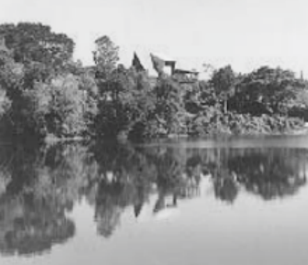
Situación en la que se encontraba la presa de Infiernillo en 1980 (Fig.14)
