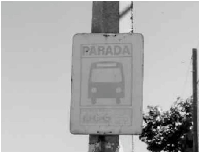
Estado en el cual se encuentran algunos señalamientos (Fig.40)
