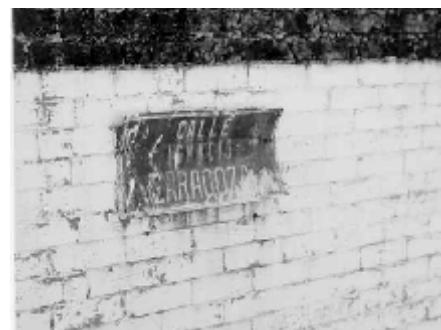
Nomenclatura deteriorada (Fig.61)
