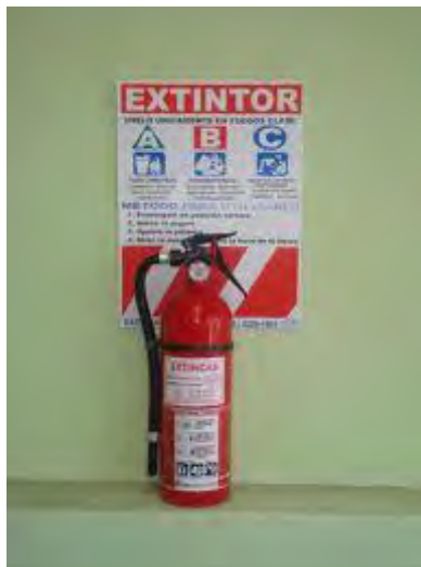
Figura III. 4. Extintor de polvo, ubicado frente al tablero.
