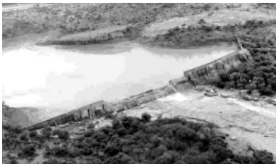
Figura 1.11 Vista aérea de la presa Dolores.
