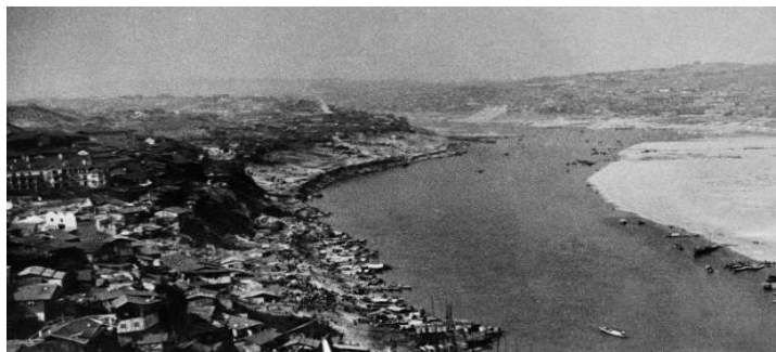
Figura 2.1 Inundación en el río Amarillo en China en 1931.
