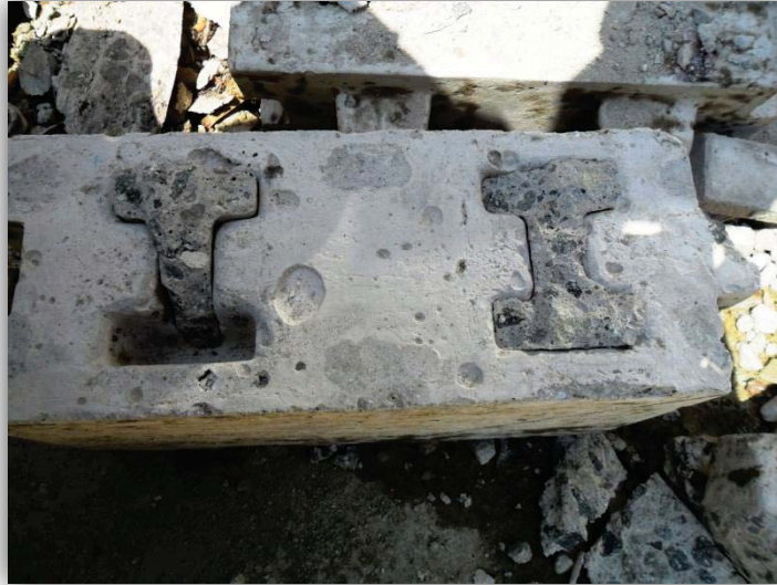
Block muestra botones incrustados de las piezas con las que existía ensamblaje.
