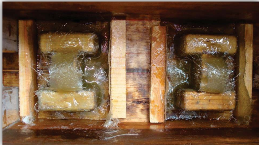
Colocación de capas posteriores de fibra de vidrio dentro del molde para obtener una medida exacta del ancho.
