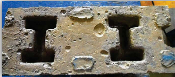
Protuberancias de concreto.
