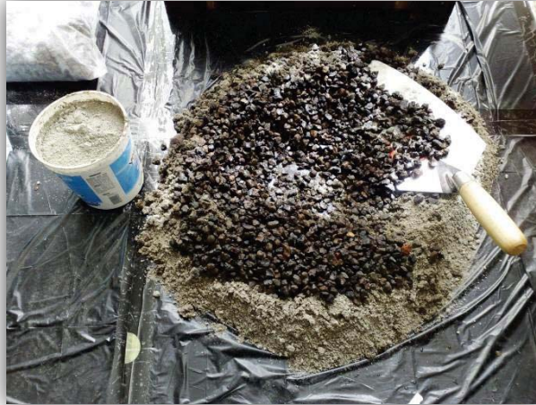
Preparación de la mezcla de concreto.
