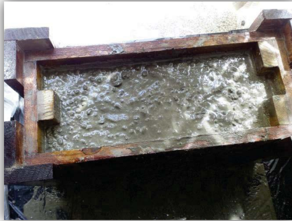
Colado del concreto.
