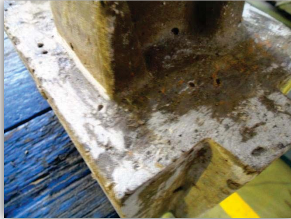
Limpieza y afinado en la parte inferior del block.
