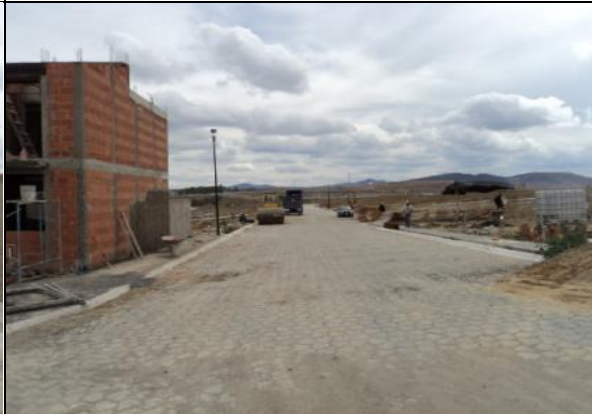
VISTA DE LA CALLE INTERIOR, CIRCUITO COLONIA.
