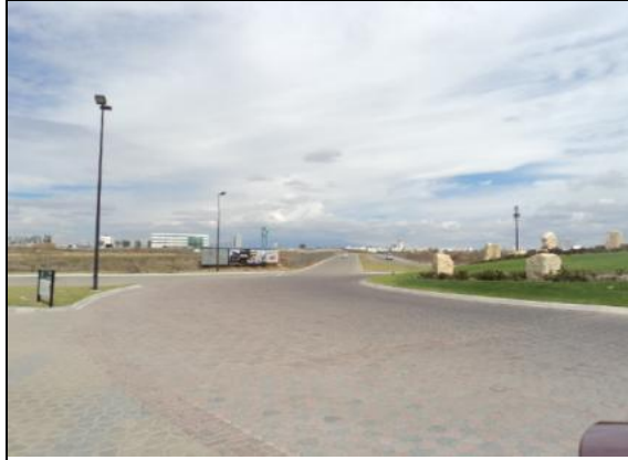
OTRO ASPECTO DE LA AV. GRAN BOULEVARD LOMAS, EN SU ETAPA INICIAL.
