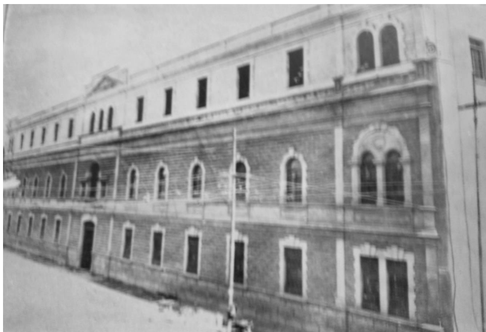
Apéndice 5: Fachada del Ex cuartel de Santa Teresa, en la calle de Mixcalco número 6. Se puede apreciar que el segundo piso no corresponde a la estructura original, lo cual fue resultado de la ampliación realizada en 1926 para albergar en ese edificio a la Escuela Nacional de Ciegos y Sordomudos.
