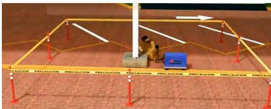
Para tareas críticas estimar áreas que pueden verse afectadas por la condición de riesgo generada con motivo de la ejecución de la actividad evaluando parámetros como presión, temperatura, toxicidad, dirección y velocidad del viento, experiencia en trabajos similares, entre otros.
