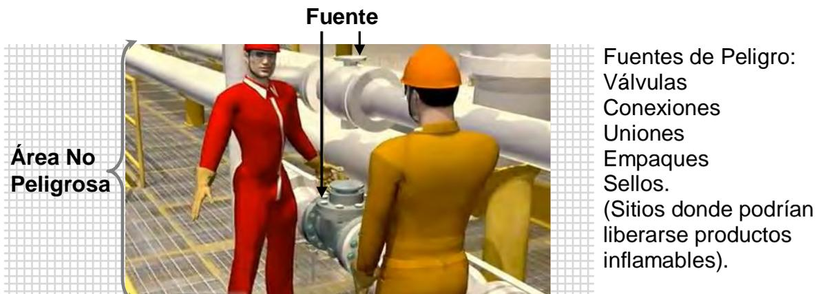
En la siguiente figura, observamos que existen áreas clasificadas o peligrosas, por lo que en éste caso, es necesario utilizar equipo electrónico intrínsecamente seguro, de acuerdo a las especificaciones de la Clase II, División 2.
