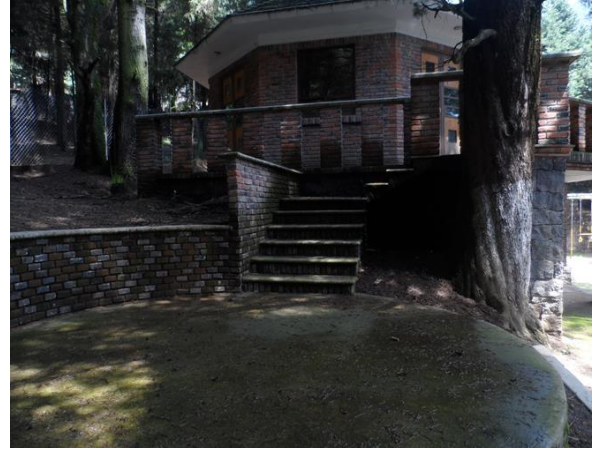
Fuente: Toma propia; 2013 *Salón de usos múltiples
