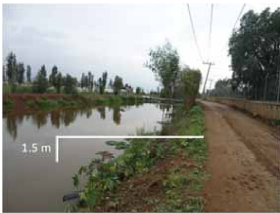
Nivel del canal con relación a la brecha existente.
