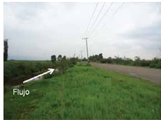
Se observa el margen derecho del canal, ya que es complicado recorrerlo en este sector por el margen izquierdo a falta de senderos o caminos.
