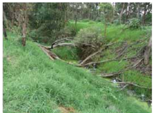
Aquí se observan algunos casos de Eucaliptos derribados sobre el canal, se observa también que el cauce se encuentra muy contaminado por objetos, descargas domiciliarias y vegetación invasiva.
