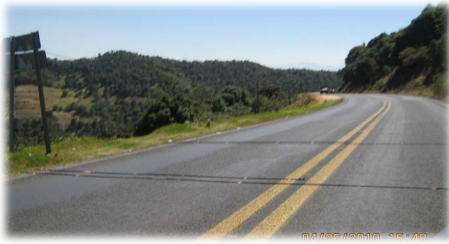
Figura 17. Contadores automáticos, dos juegos de mangueras en ambos sentidos, colocadas en forma transversal y ancladas a la carpeta asfáltica.
