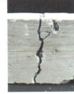
Fig. 3. Viga de concreto, con fibras ópticas embebidas, posterior a la carga excesiva aplicada.
