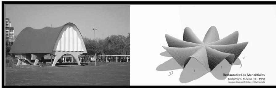
Ilustración 2.19. Estructuras tipo cascarón.
