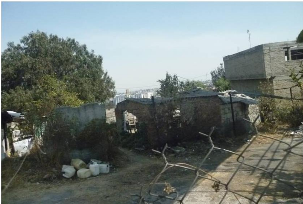
Figura 3.16 Asentamientos en las proximidades de la zona comercial de Santa Fe
