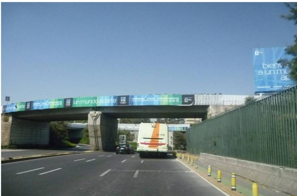
Figura 3.14 Entrada a Santa Fe por el Puente de los Poetas
