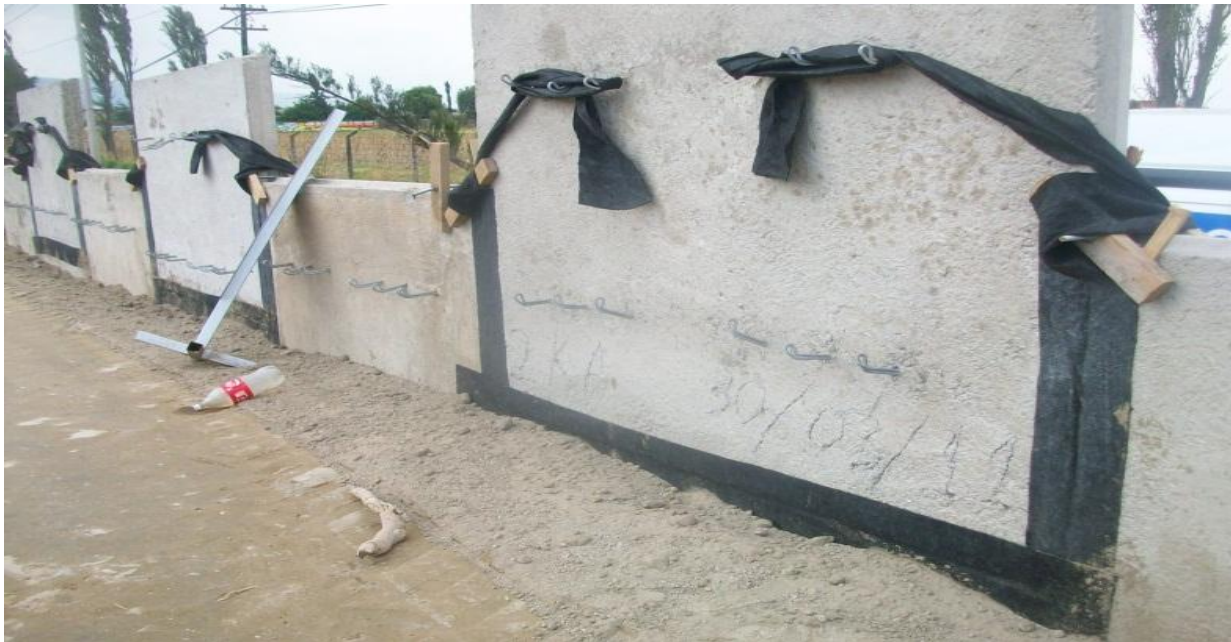
Fig. II.5.5 Colocación de juntas de neopreno en muros.
