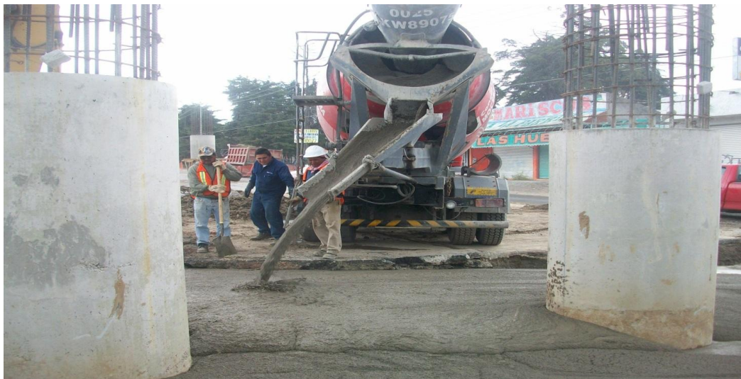
Fig. II.3.3 Se puede observar el colado con relleno fluido.
