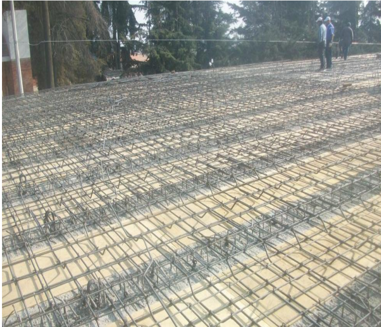
Fig. 1.2.8. Se observa la cimbra entre la separación de traveses AASHTO.
