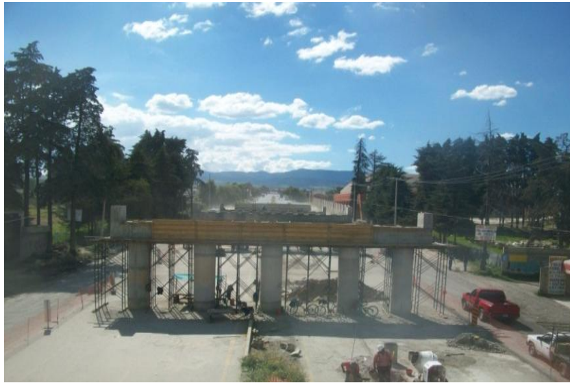
Fig. I.2.3. Se observa el armado y cimbrado del cabezal.
