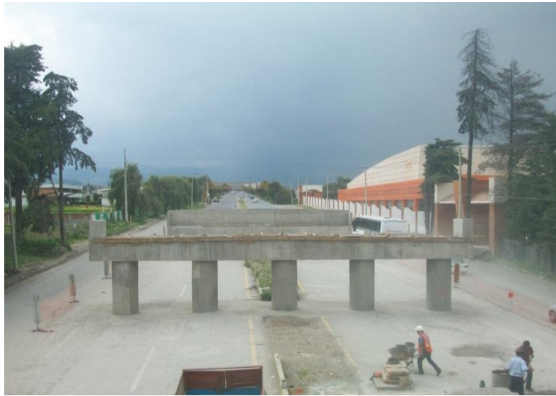
Fig. I.2.4. Se observa la construcción de inicio del puente.
