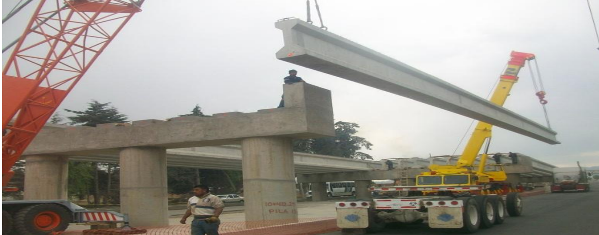
Fig. II.5.1 Montaje de traveses AASHTO con dos grúas.
