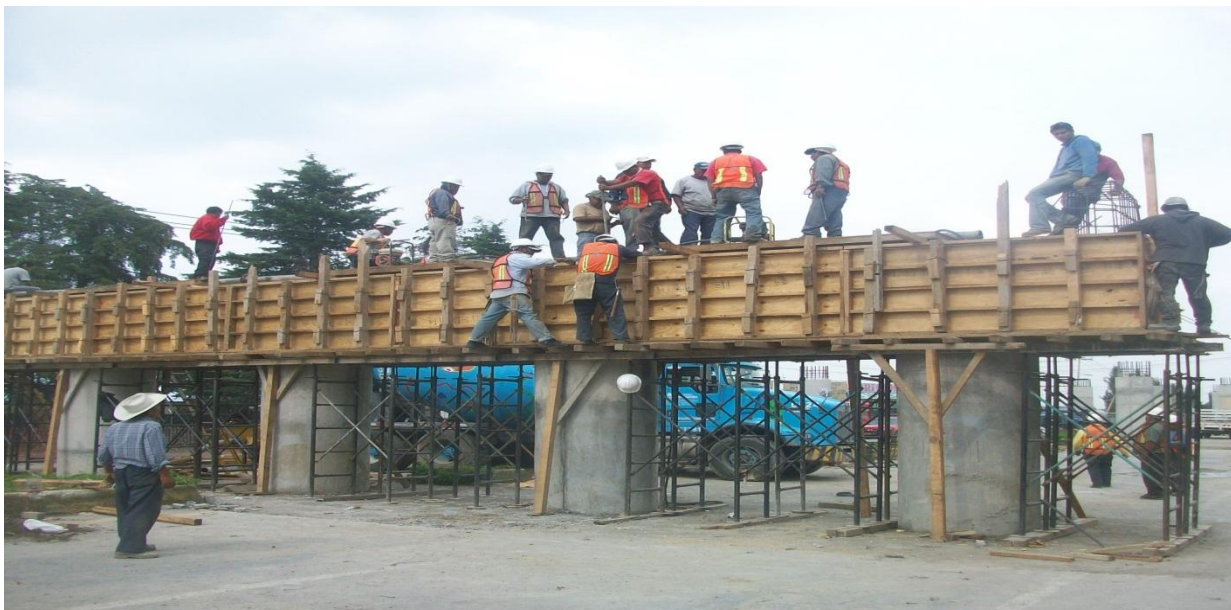
Fig. II.4.1 Cimbrado del cabezal.
