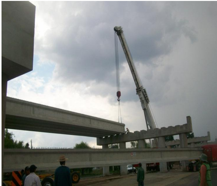
Fig. I.2.5. Se observa el montaje de traveses AASHTO.
