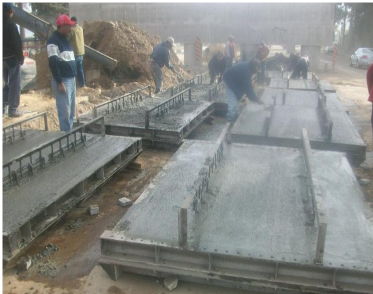
Fig. 1.2.6. Se observa la construcción de los muros de concreto.
