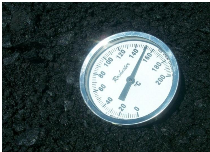
Fig. 1.2.9. El asfalto tendido tubo una temperatura mayor de 130°C.
