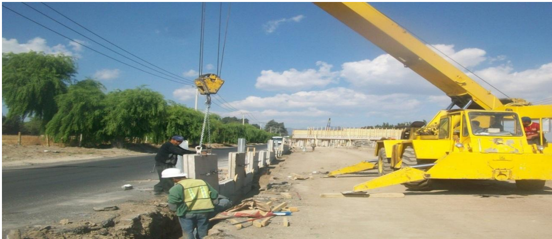
Fig. II.5.4 Colocación de estructuras para el muro mecánicamente estabilizado.
