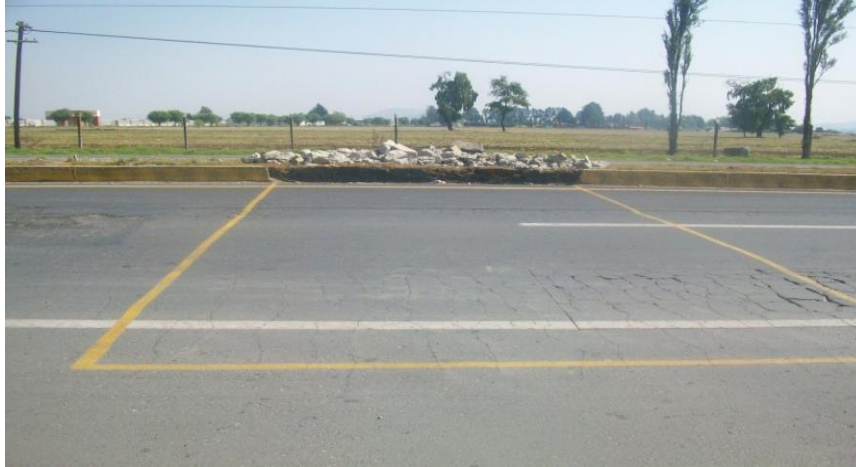
Fig. I.1.1. Se realizaron los trazos preliminares en la vialidad.
