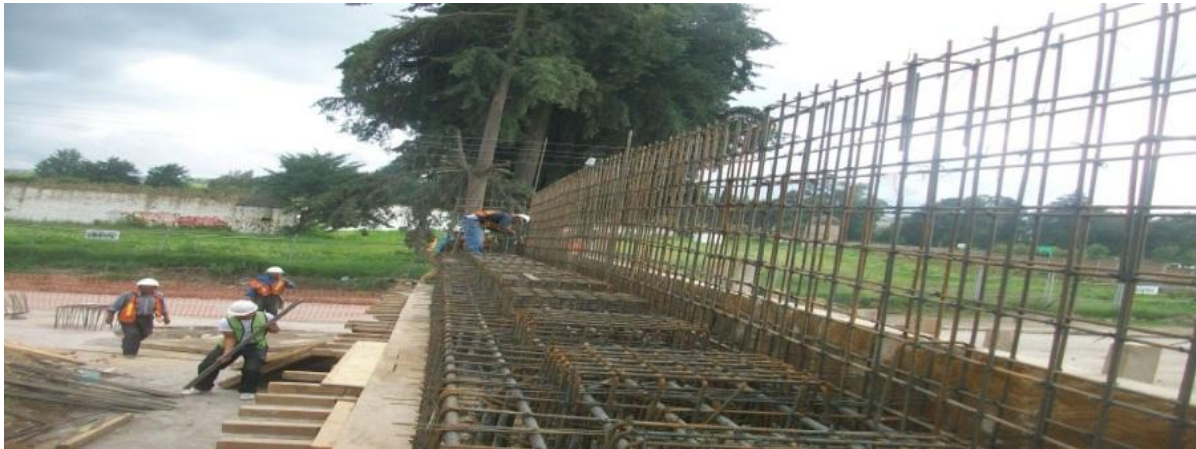
Fig. II.5.9 Construcción de muro entre losa de aproximación y traveses AASHTO.
