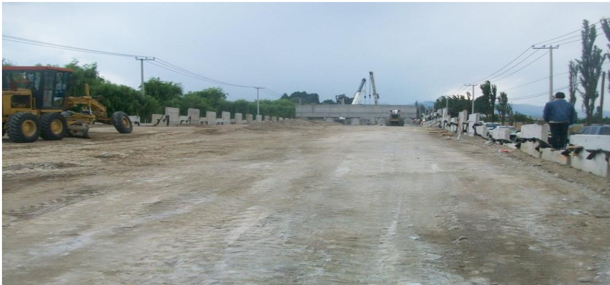
Fig.II.5.6 Relleno con tepetate en zona de terraplén
