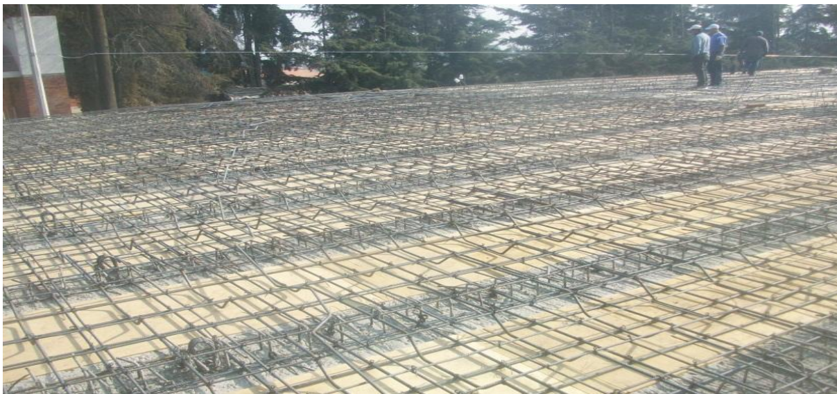
Fig. II.6.1 Se puede observar el armado y cimbra entre traveses.
