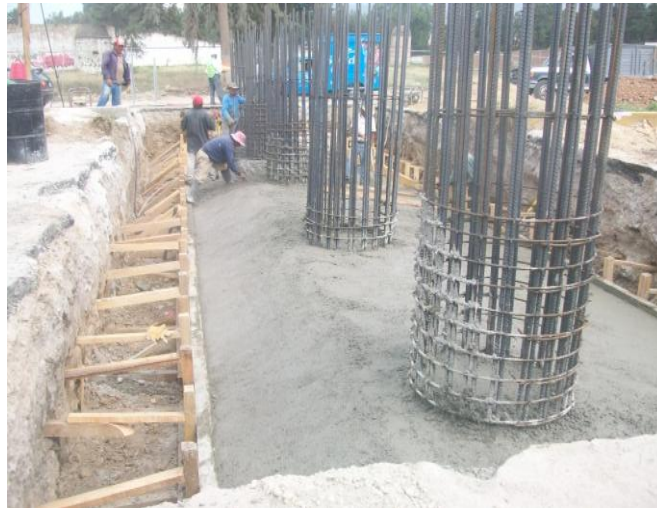
Fig. I.2.2. Se observa el colado y cimbrado de la zapata.
