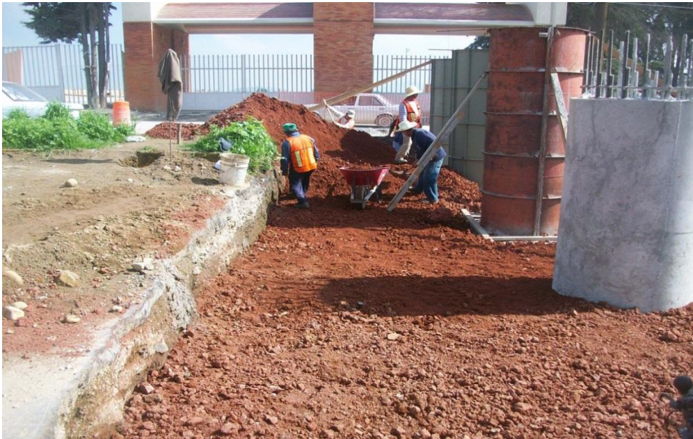
Fig. II.6.10 Relleno con tezontle de 3" a 6".
