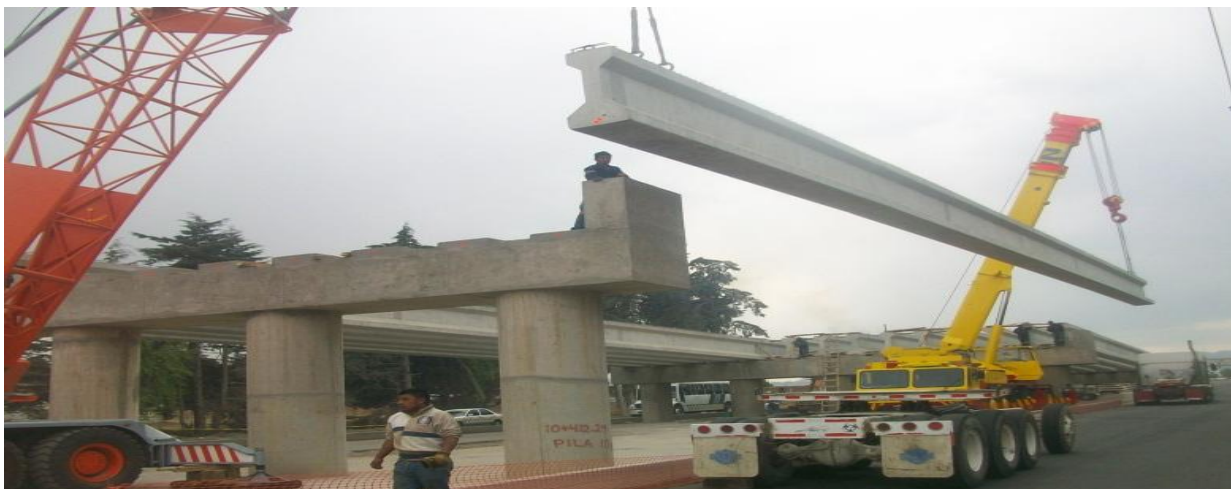
Fig. II.5.3 Se realizó el montaje con dos grúas desviando el tráfico local
