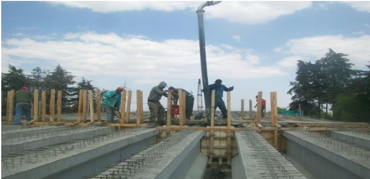
Fig. II.6.2 Se observa el colado con bomba telescópica.
