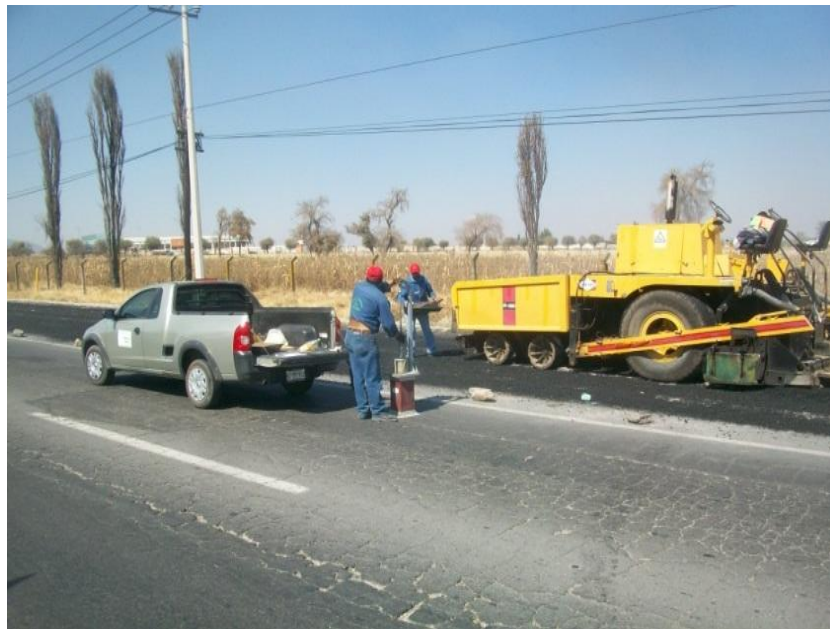
Fig. II.6.9 Compactación con rodillo neumático.
