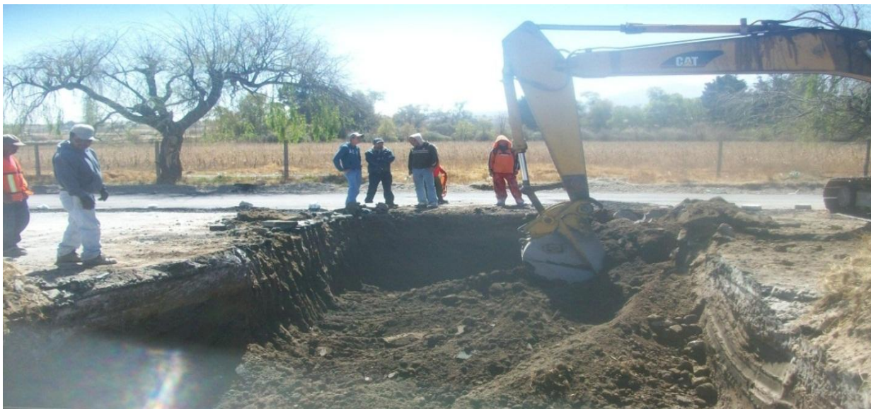
Fig. II.1.1. Excavación de zapatas por medios mecánicos
