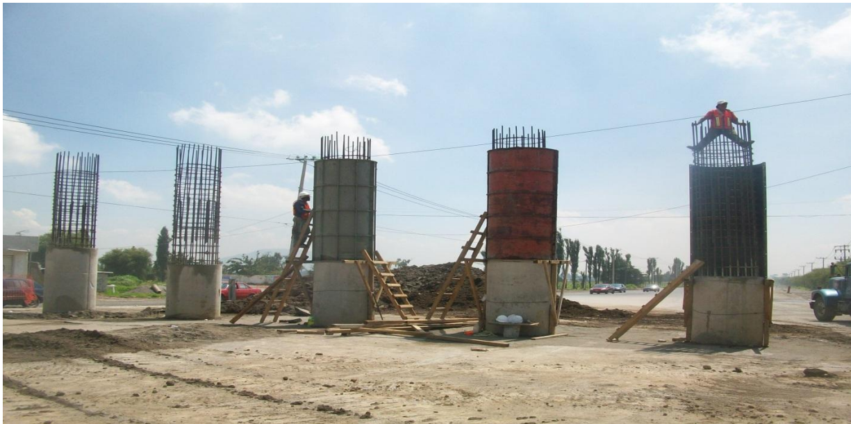
Fig. II.3.2 Se observa el alineamiento del acero
