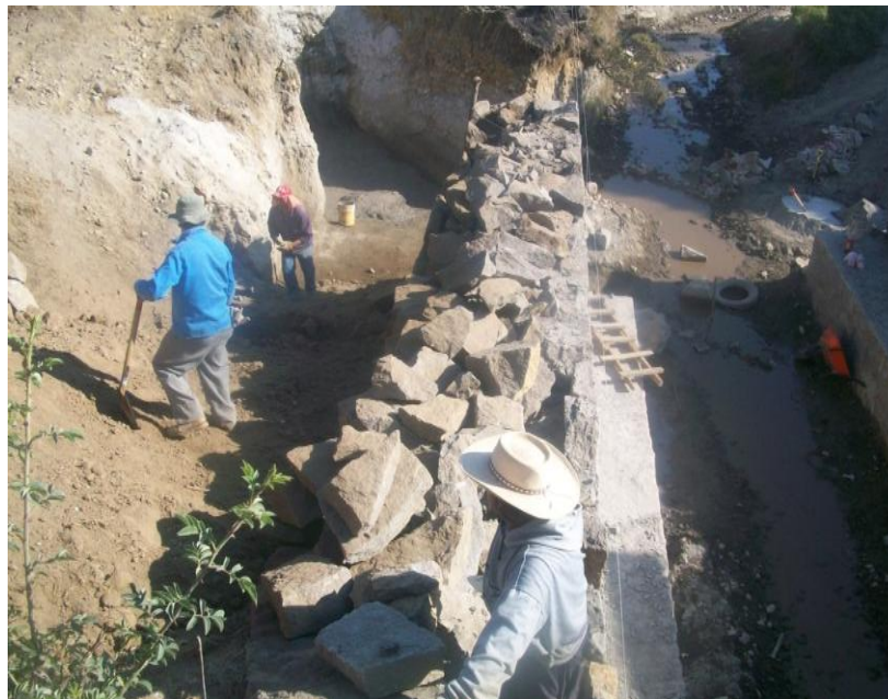
Fig. 1.3.4. Ampliación de las obras de captación de aguas pluviales.
