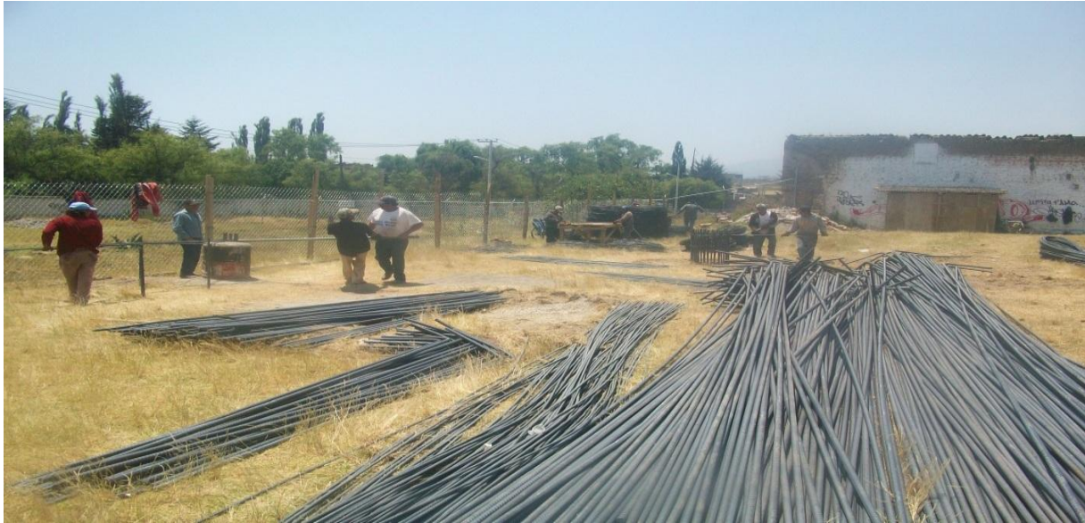
Fig. III.2.3 se puede observar el almacenamiento del acero
