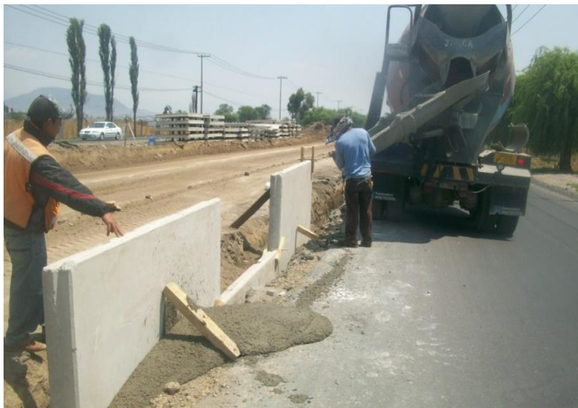
Fig. I.2.7. Se observa parte del relleno con tepetate.
