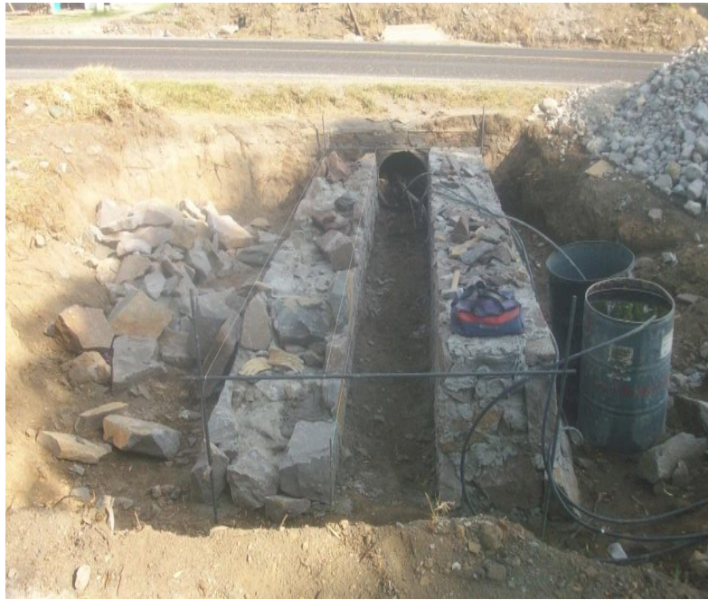
Fig. 1.3.2. Se observa la construcción de obras de drenaje.
