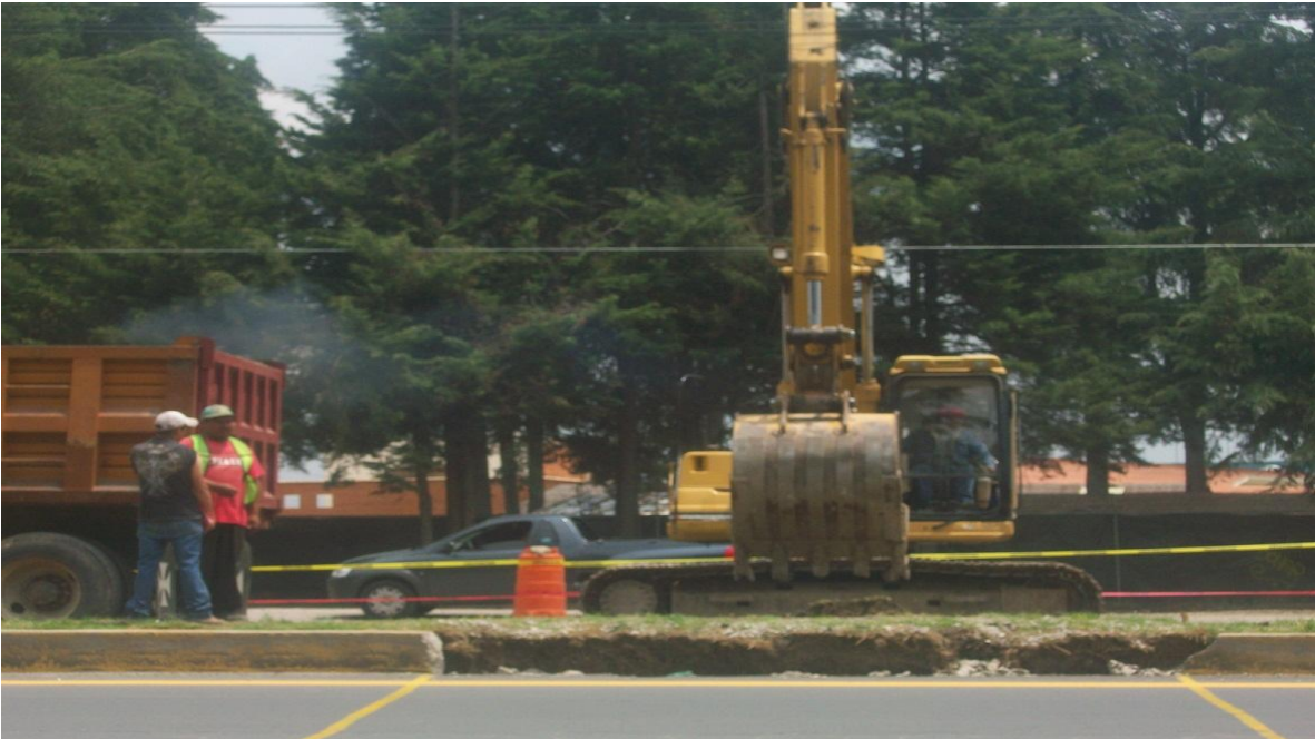
Fig. II.1. Trazo de zapata para excavación
