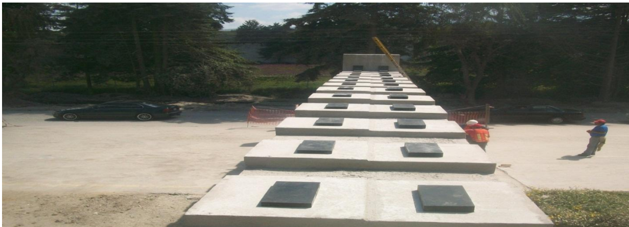
Fig. II.5.2 Se procedió a la colocación de neoprenos sobre el cabezal.
