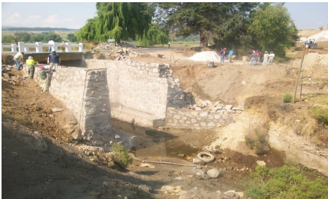
Fig. 1.3.6. Ampliación del puente del tramo troncal.
