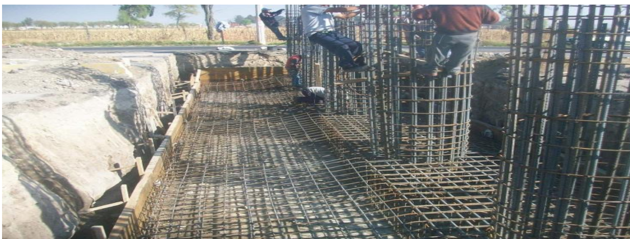
Fig. II.2.2 Armado de zapatas y columnas
