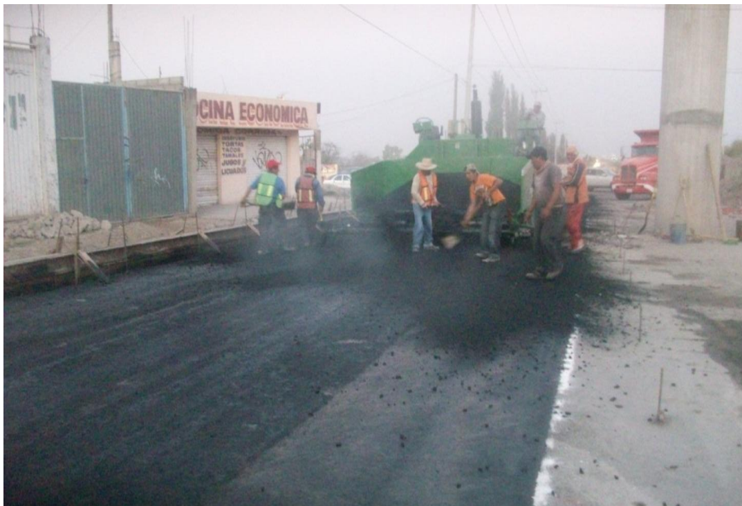
Fig. II.6.7 Tendido de mezcla asfáltica sobre las calles laterales.
