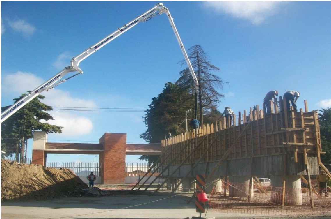
Fig. II.4.2 Colado del cabezal con pluma o trompa de elefante.
