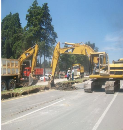
Fig. I.2.1. Se observa el inicio de la excavación de las zapatas.
