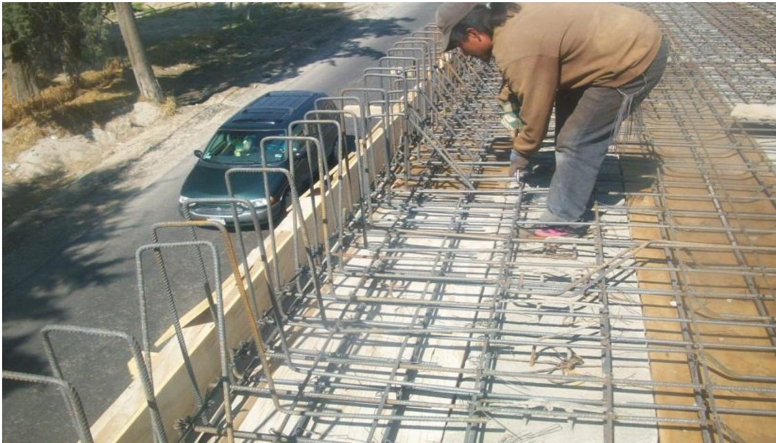
Fig. II.6.4 Armado de la losa y parapeto.
