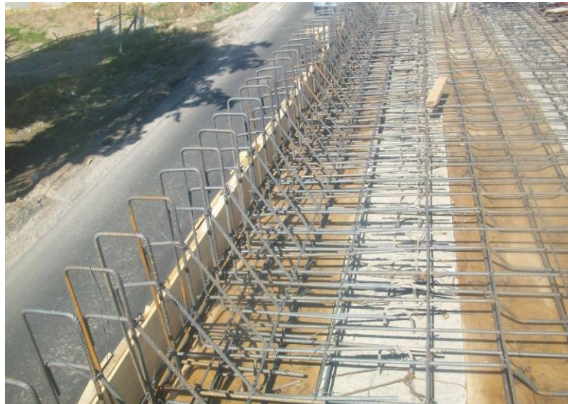
Fig. 1.2.9. Se observa el armado de guarnición y parapeto.
