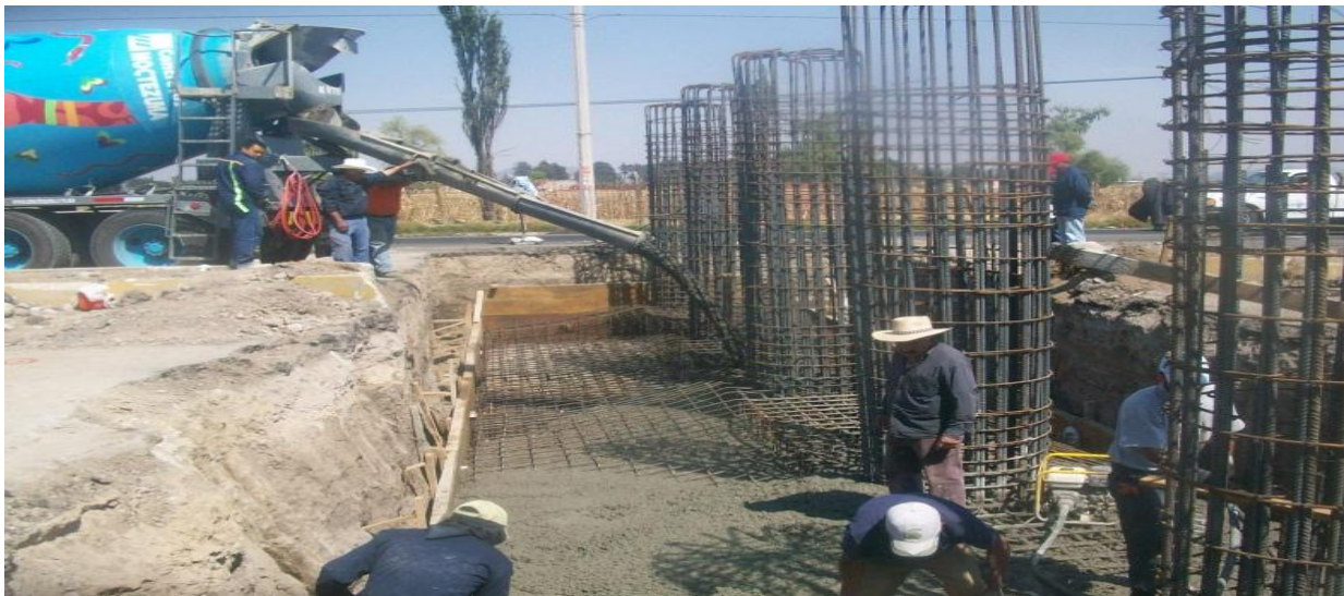
Fig. II.3.1 Colado de zapatas en tiro directo.
