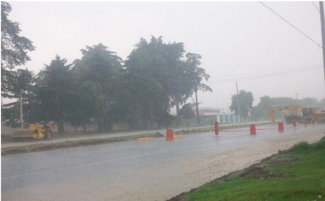
Fig. I.5.1. Se observan los trafitambos para protección vial.
