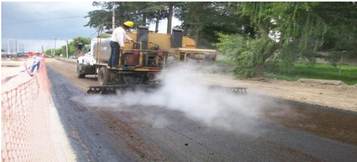
Fig. II.6.6 Tendido de riego de impregnación sobre las calles laterales.
