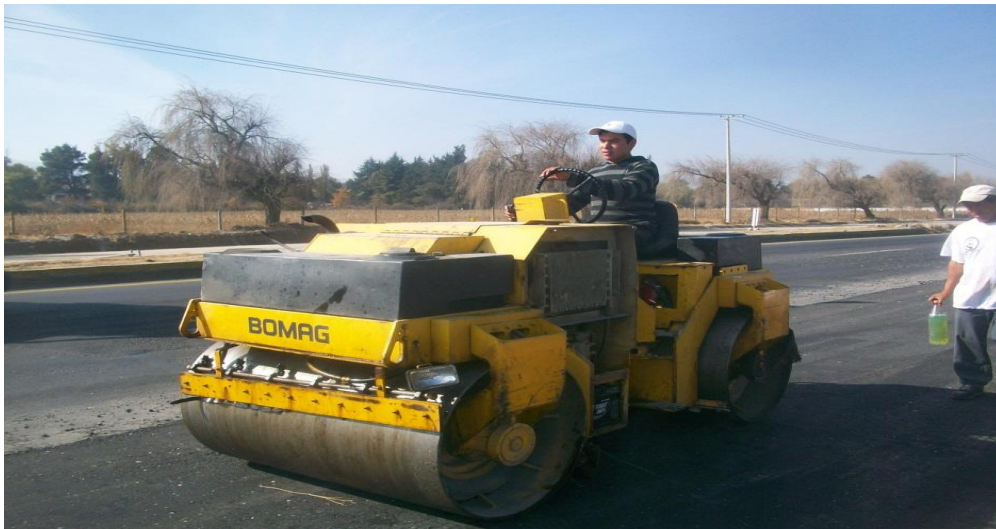
Fig. II.6.8 Se realiza la compactación de la carpeta.
