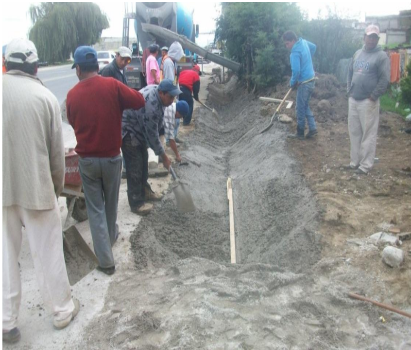
Fig. I.3.1. Se observa la construcción de cunetas.
