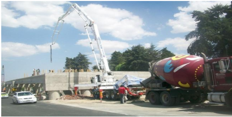
Fig. II.6.3 se observa el colado continuo de la losa
