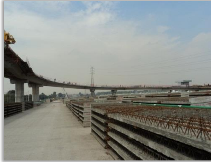
Figura 27. Avance del montaje de traves y de la carpeta asfáltica Fuente: Elaboración propia
