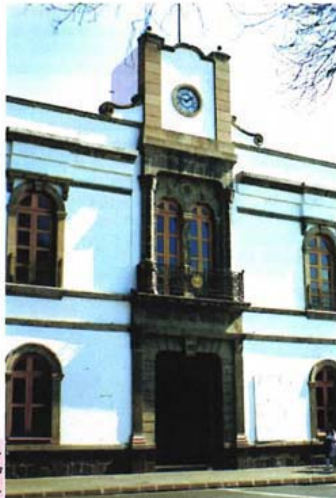
Figura 33. Fachada de la Casa de Cultura Azcapotzalco.
