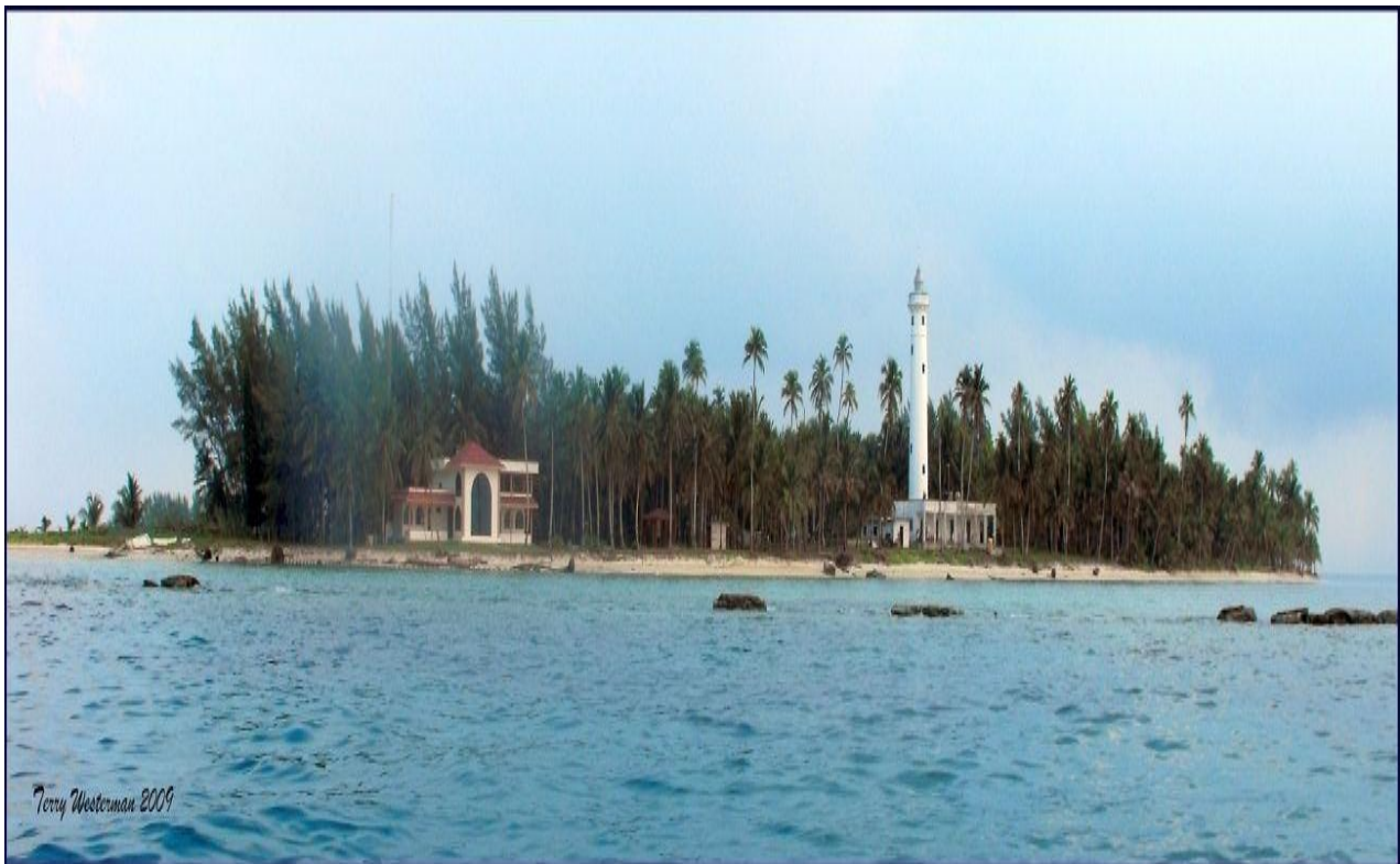
Figura 29. Casa de visitas de Pemex y campamento, Faro.
