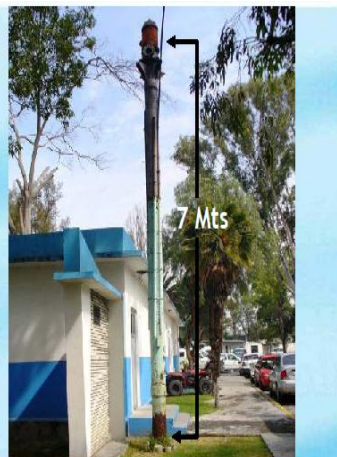
Pozo que demuestra el hundimiento en San Juan de Aragón en el periodo 1936-2005.
