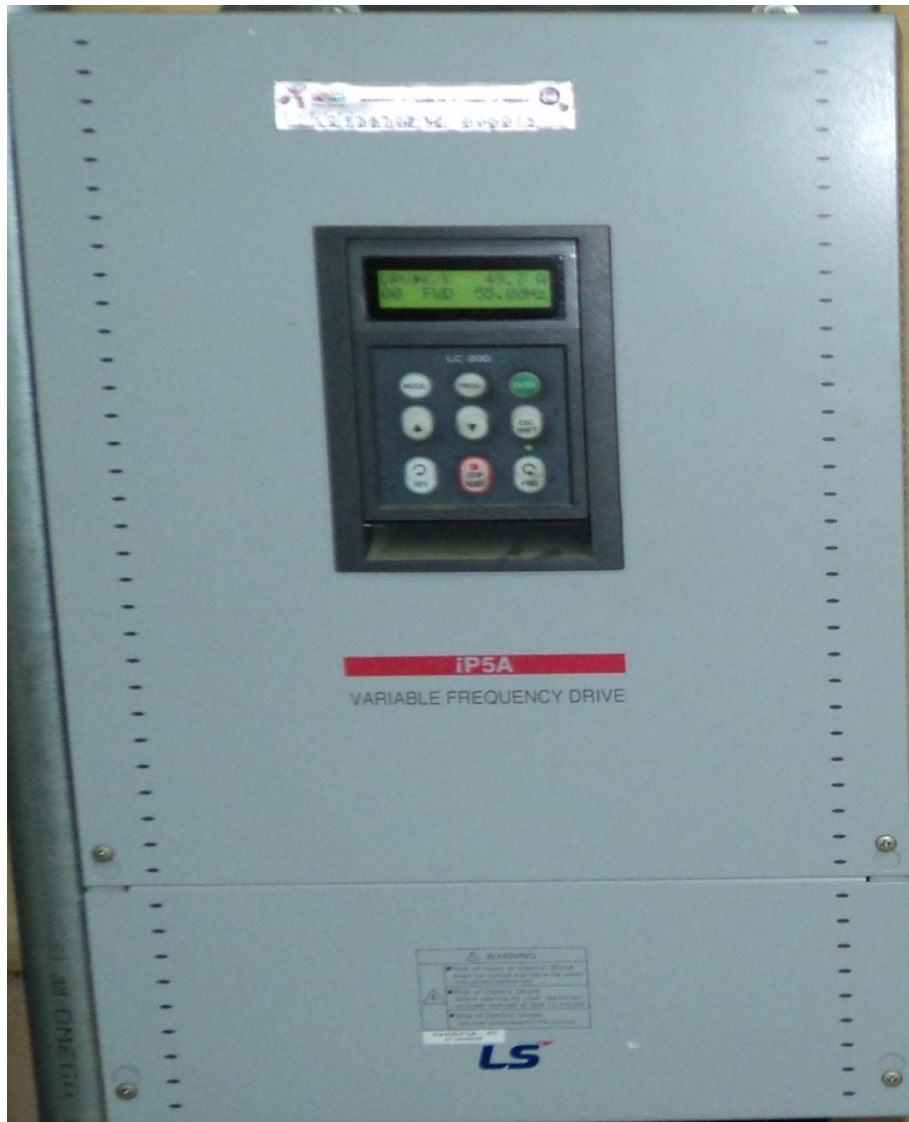
Fig. 2.24 Variador de Frecuencia a 45 Hz.
