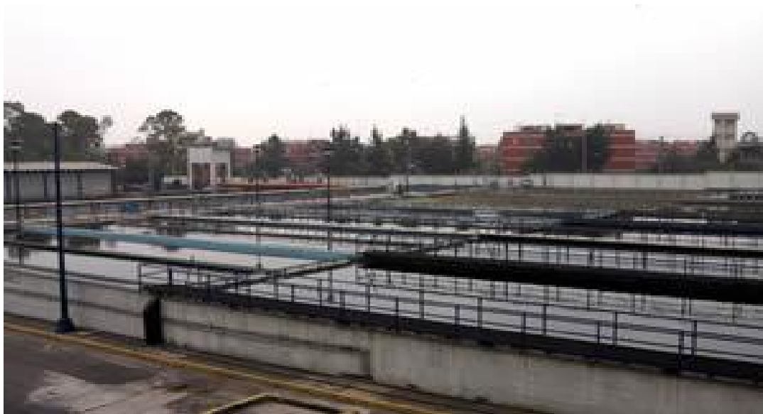
Fig. 1.7. Planta De Tratamiento De Aguas Residuales Cerro De La Estrella, Delegación Iztapalapa.
