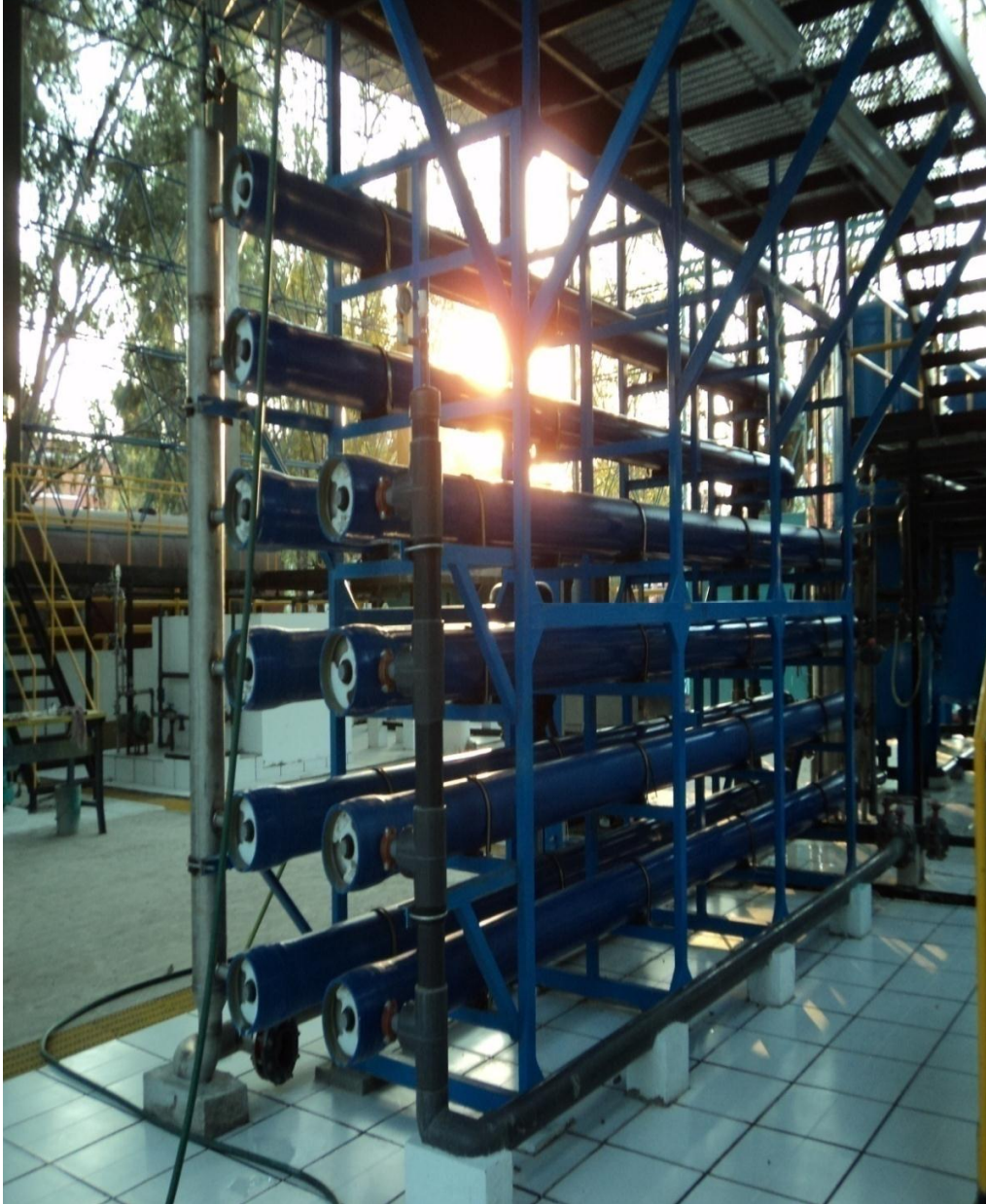
Fig. 2.25 Válvula de Purga de Osmosis Inversa.
