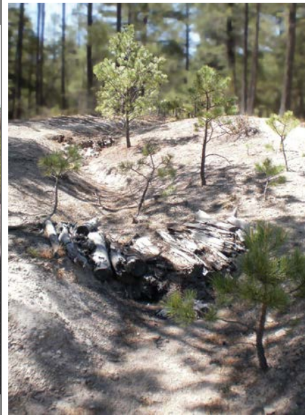
Imagen 22. Las trincheras en los arroyos retienen el suelo y otros materiales
