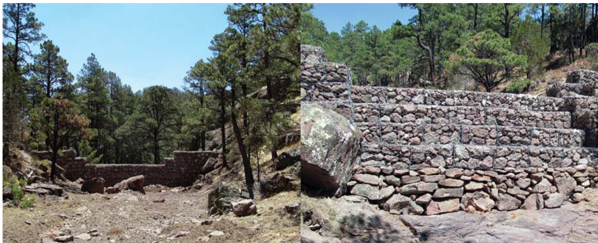
Imagen 23. El gavión es la obra de mayor infraestructura que CONTEC ha promovido en el ejido El Consuelo; es parte de una estrategia de manejo de cuencas en la zona
