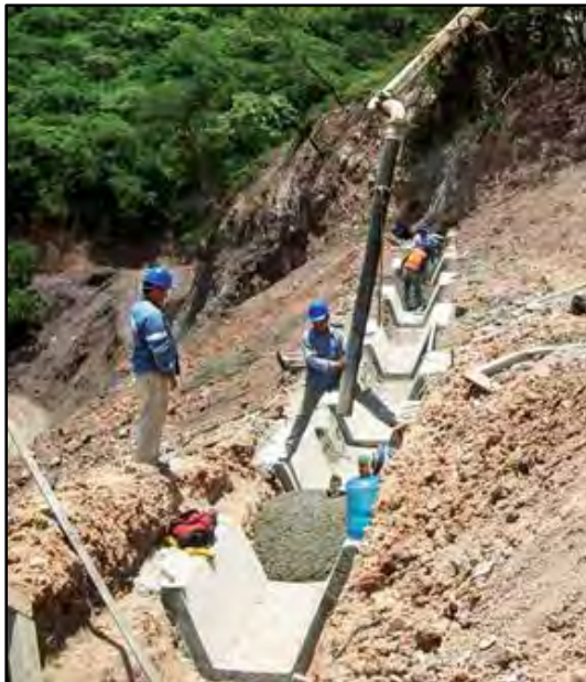
Figura 4. En esta imagen se observa la construcción de una contracuneta. Imagen tomada de: Referencia bibliográfica No. 16
