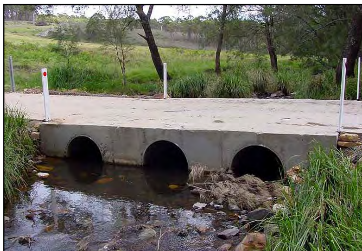
Figura 9. Anónimo, Vado con alcantarillas, usando tubos múltiples de alcantarillas para desalojar el flujo a través de los mismos. Imagen tomada del sitio: http://www.roladuct.com.au (Fecha de actualización: 18 Octubre 2012.)
