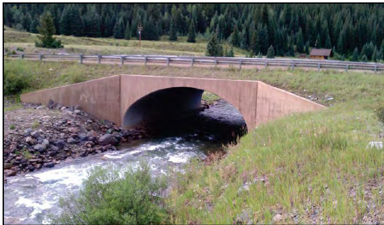
Figura 26. Alcantarilla de arco de fondo abierto. Imagen tomada de: Referencia bibliográfica No. 6
