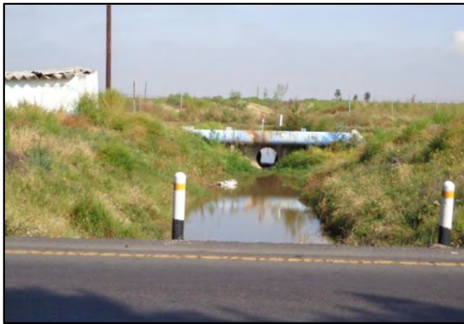
Figura 28. Luis Carlos Moreno Padilla, En esta fotografía se observa el cruce del camino con un drenaje artificial, para salvarlo, se empleó una alcantarilla de tubo de concreto. Autopista Peñón-Texcoco, Texcoco Edo. de México, octubre de 2012.
