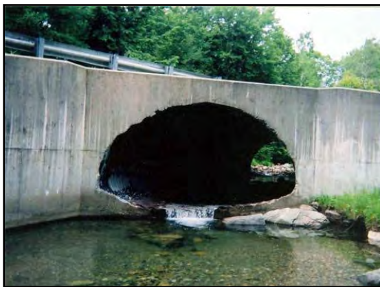
Figura 21. Alcantarilla de Tubo -arco de lámina de metal corrugado de acero. Imagen tomada del sitio: http://www.mass.gov/dfwele/der/freshwater/rivercontinuity/bronsonbrook.htm (Fecha de actualización: 26 de Octubre de 2012).
