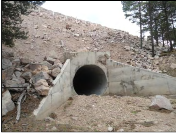
Figura 20. M. en I. Arroyo Hernández Patrocinio, Fotografía en la que se aprecia una alcantarilla de tubo de concreto, con sus respectivos muros de cabeza y aleros los cuales sirven para impedir que el material del terraplén invada la entrada y salida de la alcantarilla, así como también contribuyen a mejorar el funcionamiento hidráulico de la alcantarilla. Autopista Durango-Mazatlán, julio de 2012.
