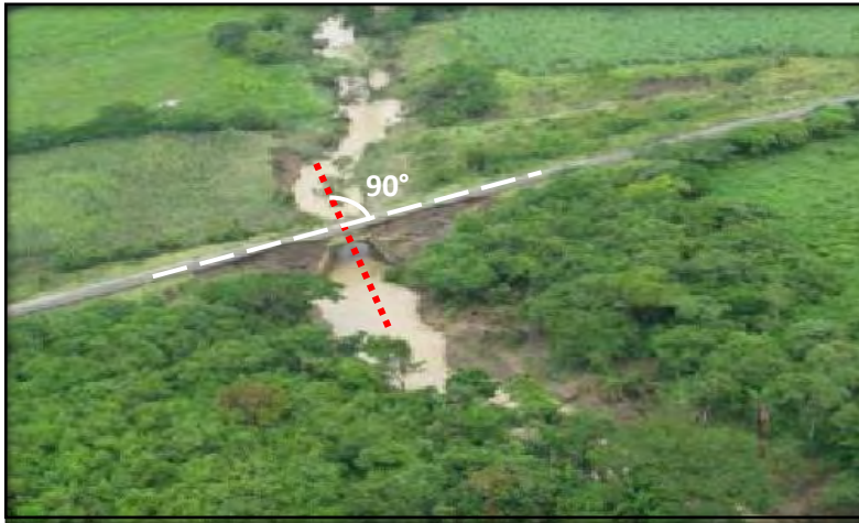
Figura 29. Anónimo, En la imagen se aprecia como el cauce cruza de manera perpendicular el eje longitudinal de la carretera. Carretera 180 (Costera del Golfo), Veracruz. Imagen tomada del sitio: http://www.slideshare.net/angelarmengol/danos-carreteras-veracruz-sct (Fecha de actualización: 4 de Noviembre de 2012).
