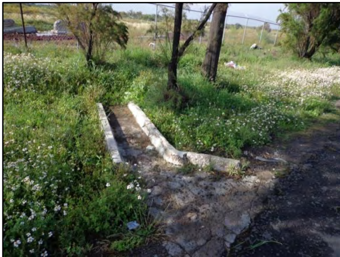
Figura 6. Luis Carlos Moreno Padilla, En esta fotografía se observa una pequeña estructura de lavadero que forma parte de las obras de captación y defensa de la Autopista Peñón-Texcoco, Texcoco Edo. de México, octubre 2012.
