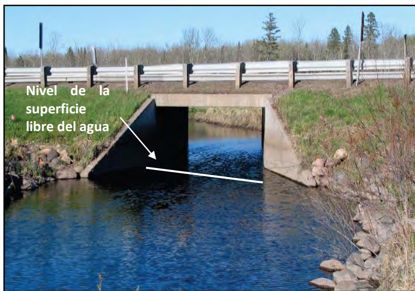
Figura 59. Alcantarilla de cajón trabajando a superficie libre. Imagen tomada de: Referencia bibliográfica No. 6
