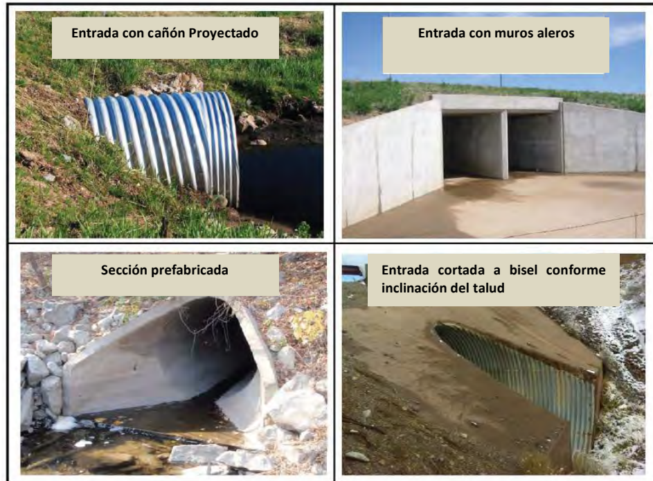
Figura 11. Cuatro tipos usuales de entrada. Imagen tomada de: Referencia bibliográfica No. 6
