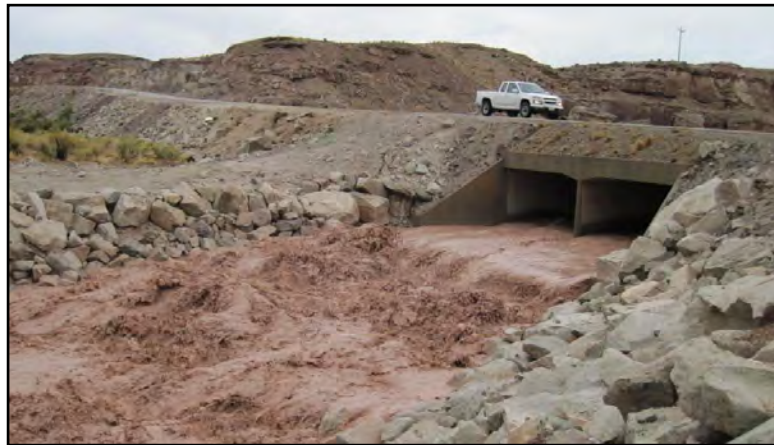
Figura 1. Alcantarilla de cajón múltiple que da paso al flujo de una corriente bajo la carretera. Imagen tomada del sitio: http://blog.udot.utah.gov/page/40/ (Fecha de actualización: 14 de Octubre de 2012).
