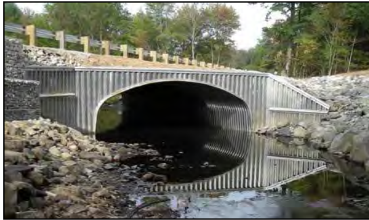
Figura 24. Alcantarilla de cajón de metal (aluminio estructural). Imagen tomada del sitio: http://www.metal-culvert.com/culvert/aluminum-box-culvert.html (Fecha de actualización: 28 de Octubre de 2012).
