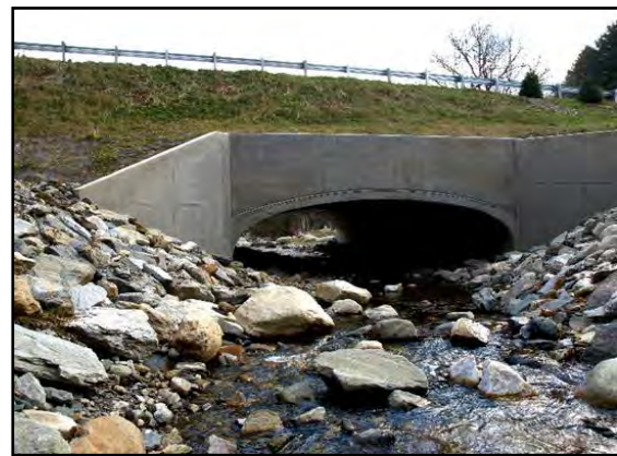
Figura 22. Alcantarilla de arco de concreto reforzado. Imagen tomada del sitio: http://www.vermontbiz.com/news/december/vermont-appeals-fema-decision-deny-public-assistance-culvert-repair (Fecha de actualización: 11 de Enero de 2013).
