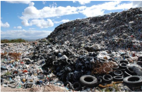
Figura 2. Residuos sólidos sin cubierta diaria
