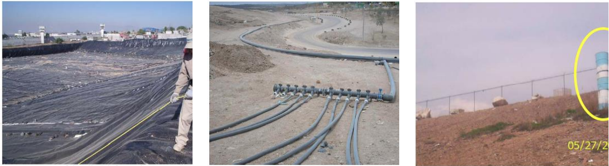
Figura 15. Desarrollo de infraestructura: construcción de la ampliación del relleno y manejo de biogás
