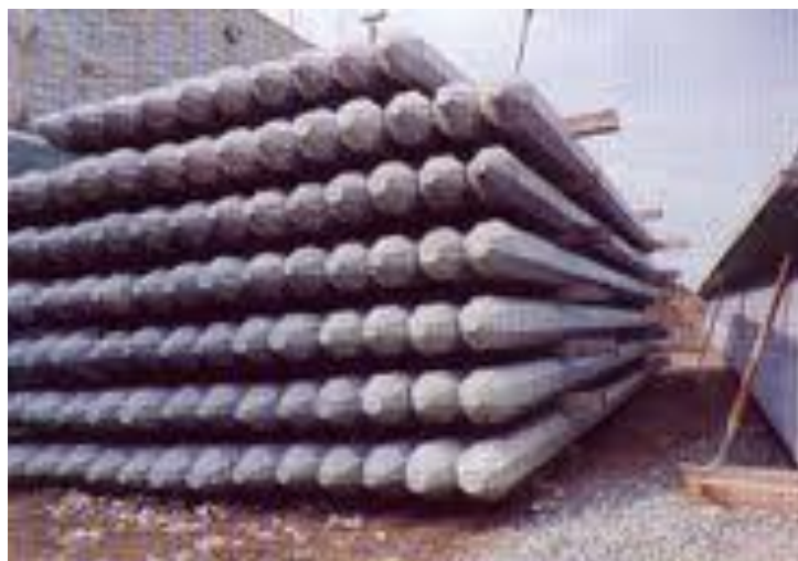
Fig. 3.24. Almacenaje de pilotes.
