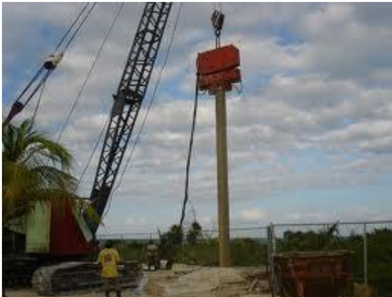
Fig. 3.11. Pilote hincado con vibración.
