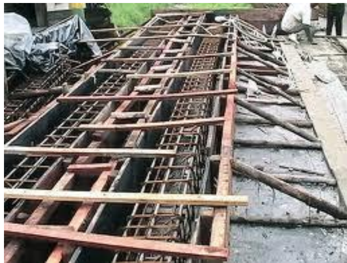
Fig. 3.23. Colado de pilotes
