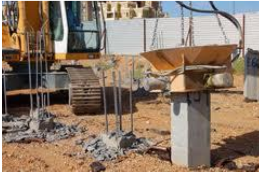
Fig.3.25. Corte de exceso de longitud en pilotes.
