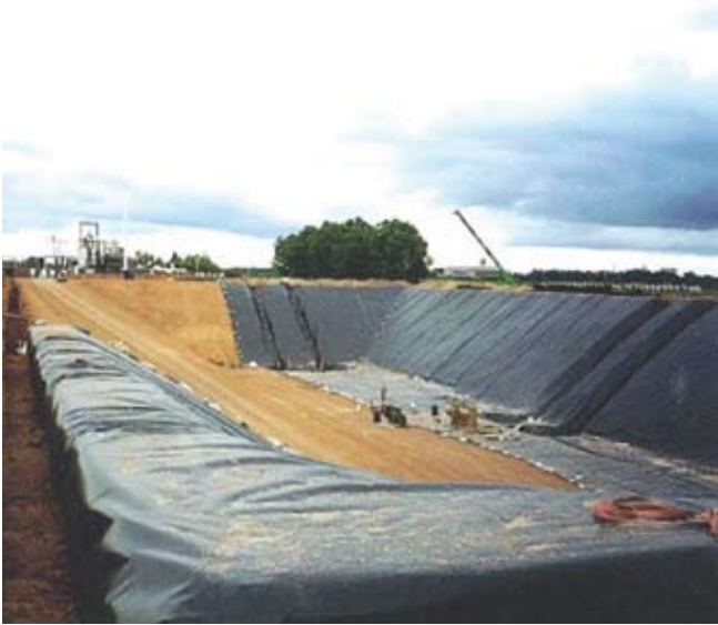
Fig. 4 Colocación de membrana plástica del relleno sanitario. Fuente: www.enestahora.com.mx
