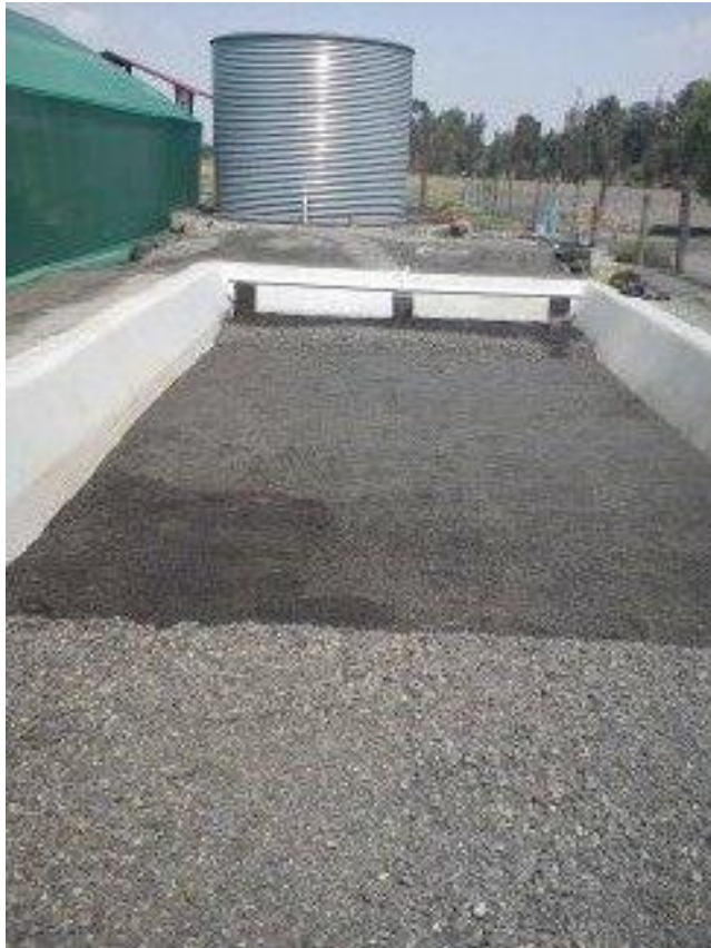
Figura 7. Construcción de un humedal artificial para fines acuícolas (González González, 2011)
