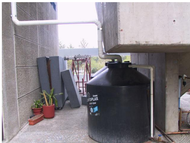
Figura 18 - Cisterna prefabricada de plástico 42
