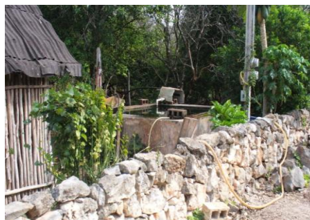
Fig. 13 Fachada casa típica maya.
