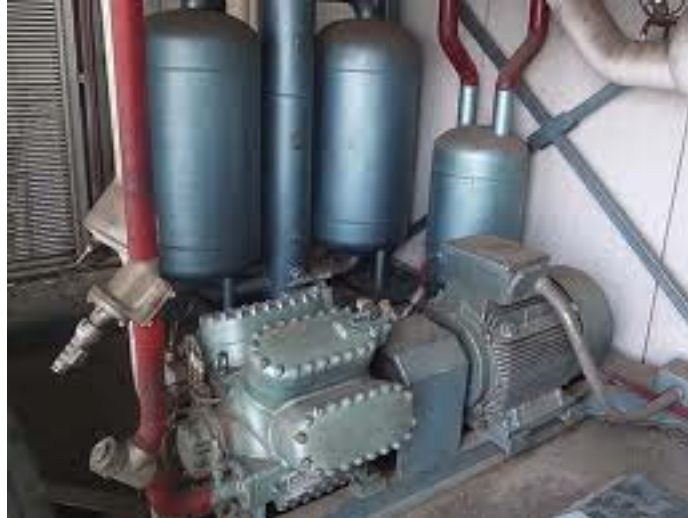
Figura 3.20 Compresor alternativo en W. http://goo.gl/gyy4z
