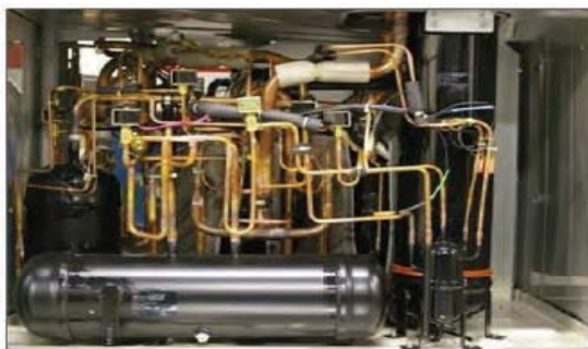
Complejidad de un Sistema con “Inverters”
