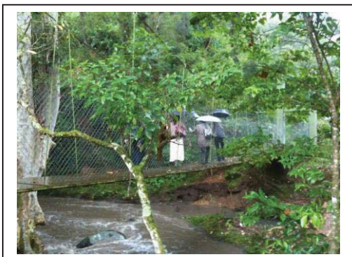
Ilustración 103: Puente construido en la colonia, por el Departamento de Obras Públicas Municipales, gracias a la gestión de los vecinos, realizada con el proyecto de los estudiantes.
