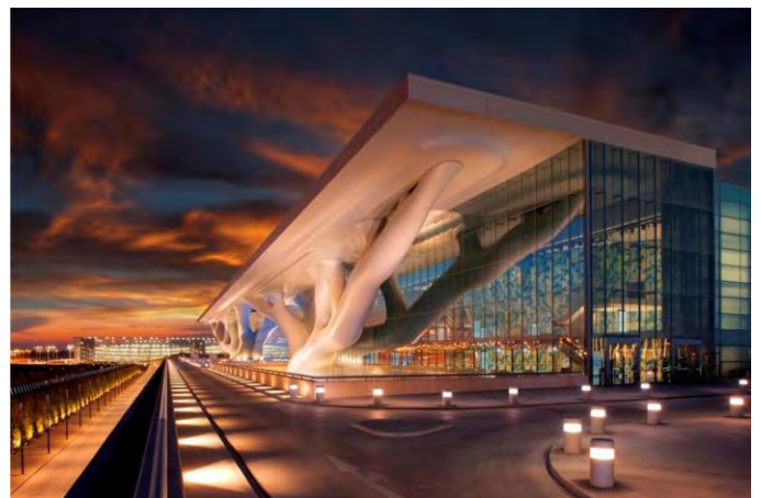
Imagen 1-20. Entrada al Centro Nacional de Convenciones de Qatar usando metodología ESO (imagen tomada de www.qatarconvention.com ).
