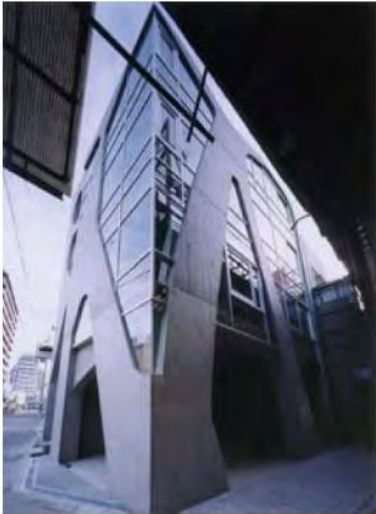
Imagen 1-21. Edificio de oficinas diseñado mediante el método ESO (Xie, Zuo, Huang, Tang, Zhao, & Felicetti, 2011).
