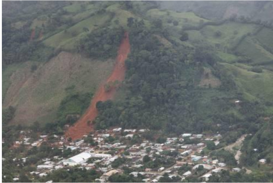
Figura 4. Aspecto de la comunidad Reforma y Planada, una de las zonas afectadas.
