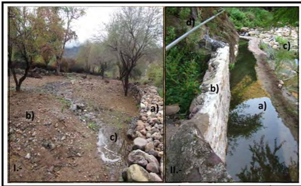
Figura 16: I.- el proceso de construcción de un nuevo tajo en la comunidad de Organitos donde a) se muestra el “ tajo ” o muro de piedra, b) el tipo de suelo original de composición rocosa y c) proceso de captura de “lamedal” II.- Proceso de construcción de una nueva acequia en la comunidad de Organitos donde se observa a) una acequia ya existente, b) el muro de contención de la acequia en proceso de construcción y c) el lecho del río Mezquital.
