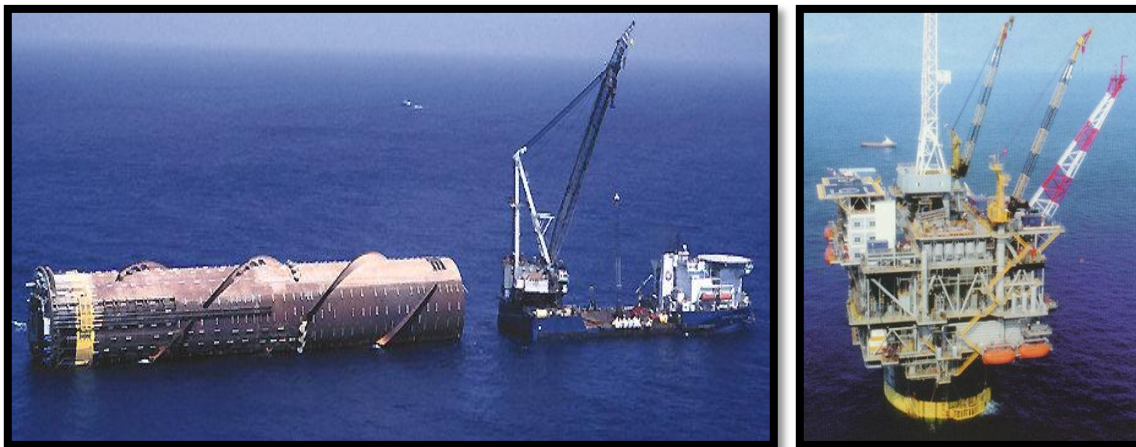
Figura 3.6 Una plataforma SPAR debe ser arrastrada hasta su ubicación antes de que se le instale los equipos. [www.offshore-technology]
