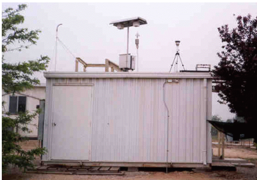
Figura 5.7. Estación de monitoreo de Riverside (California).
