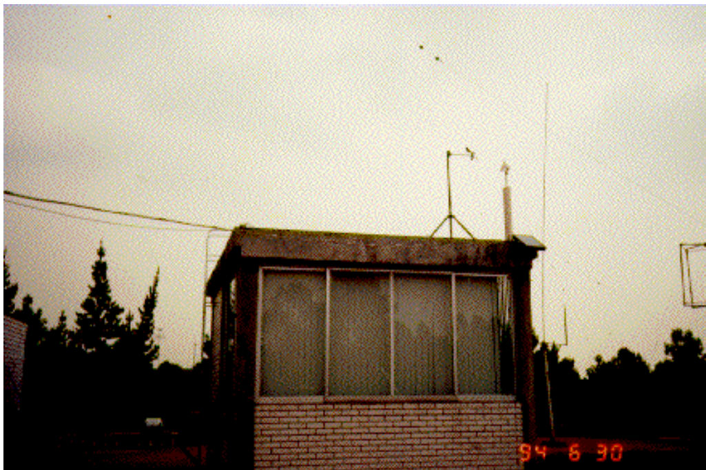
Figura 5.4. Estación de monitoreo del Centro de Ciencias de la Atmósfera.
