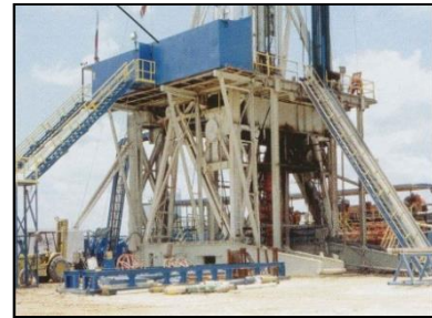
Fig. 4 Subestructura y piso de perforación
