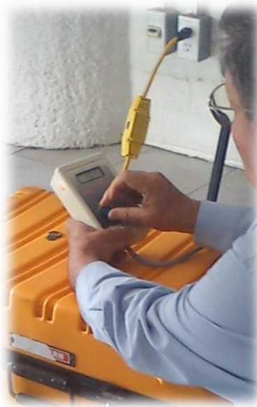
Figura 33. Prueba a los Contactos con Interruptores de Falla a Tierra (GFCI).
