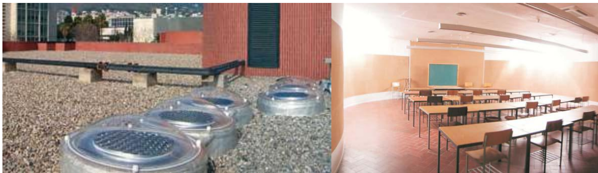
Figura 2.4. Instalación de lucernarios en Aulas E.T.S.A.B, Universidad Politécnica de Cataluña, 2004.
