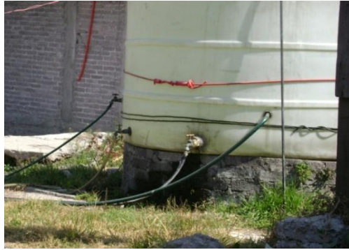
14/febrero/2011 El Santuario, Iztapalpa, DF. Conexiones domésticas, con manguera
