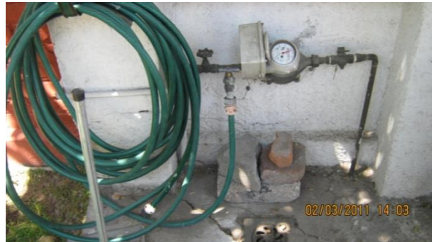
02/marzo/2011 Rinconada Coapa, Tlalpan, DF. Manguera conectada a la toma principal
