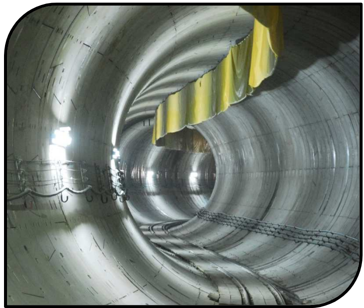
Figura No. 22 Túnel excavado con tuneladora tipo EPB.
