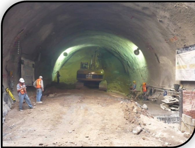
Figura No. 23 Frente de excavación del túnel convencional
