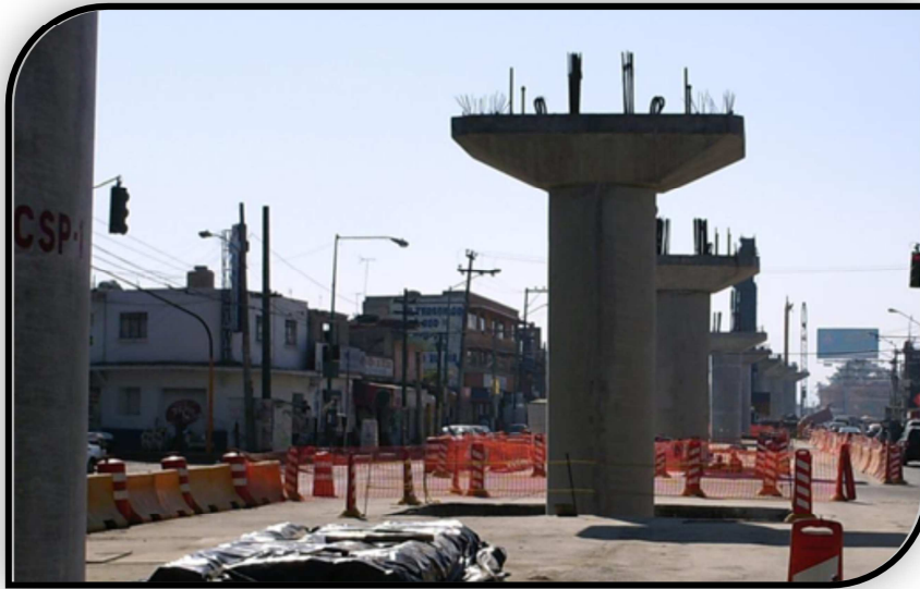
Figura No. 19 Columnas con cabezales colocados pertenecientes al tramo elevado
