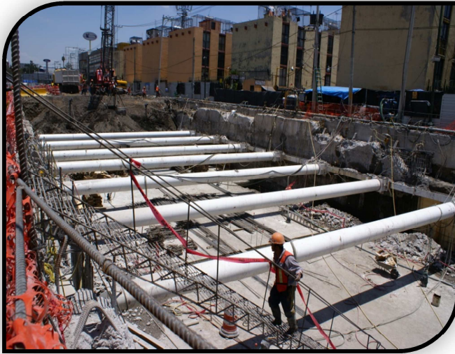
Figura No. 17 Construcción de la estación Mexicaltzingo
