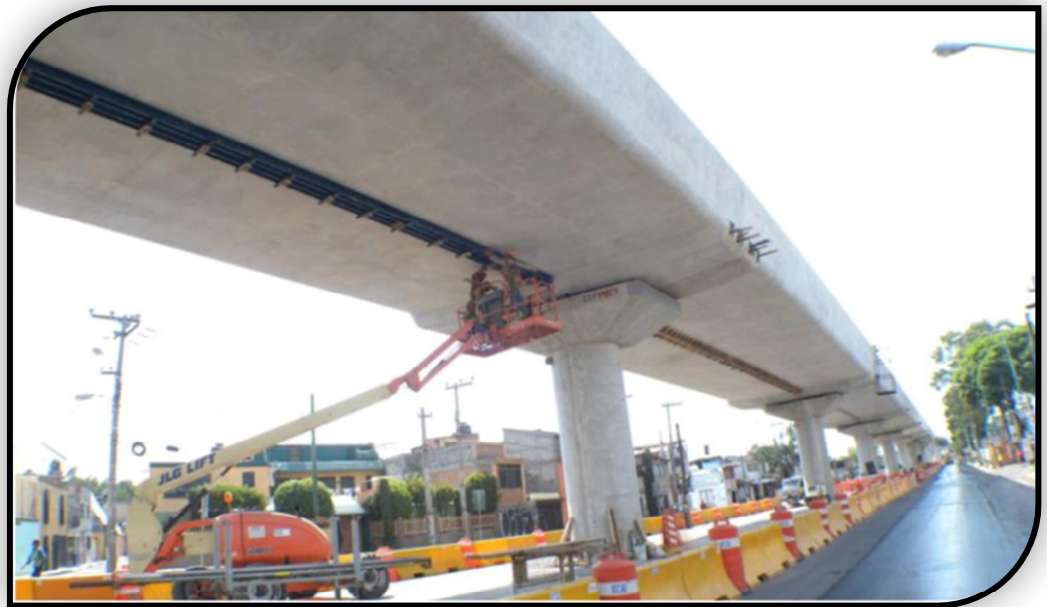
Figura No. 20 Tramo elevado de la Línea 12 del metro terminado.
