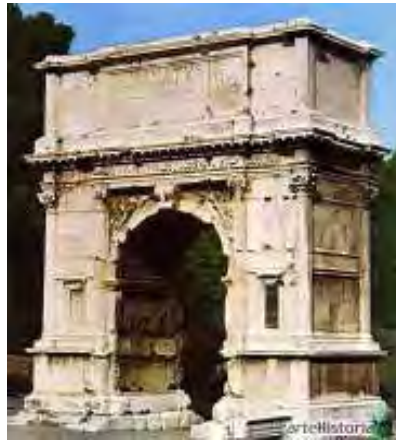
FIGURA 11. El Arco de Tito (Adosado al muro medieval) iniciado por Raffaele Stern en 1818 y terminada por Giuseppe Valadier
