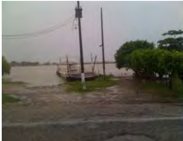
FIGURA 54. Contaminación visual ocasionada por infraestructura eléctrica.
