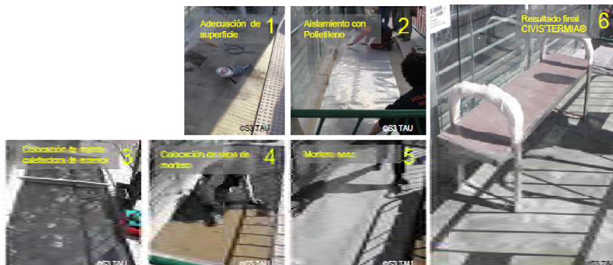
FIGURA 50. Proceso de instalación
