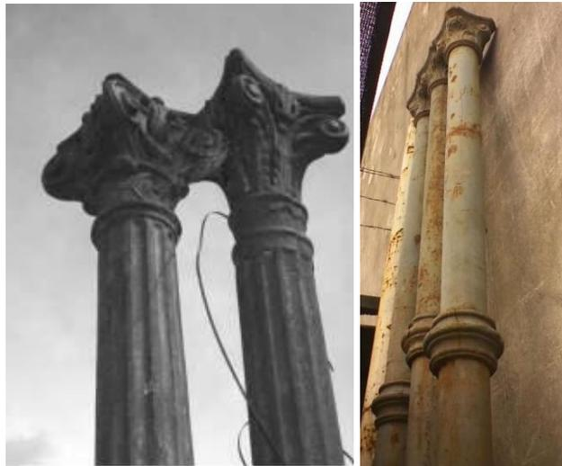
Fig. 33.- Sistema constructivo con columnas de hierro fundido.
