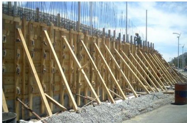
Fig. 20. Madera para Cimbra.
