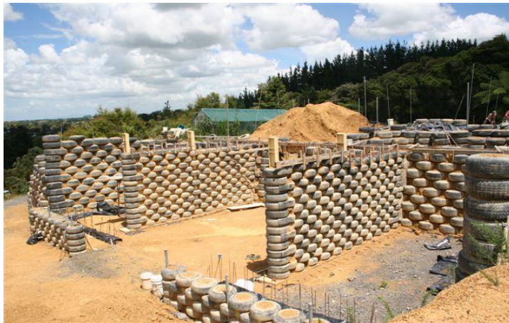
Fig. 37. Construcción de un Earthship.
