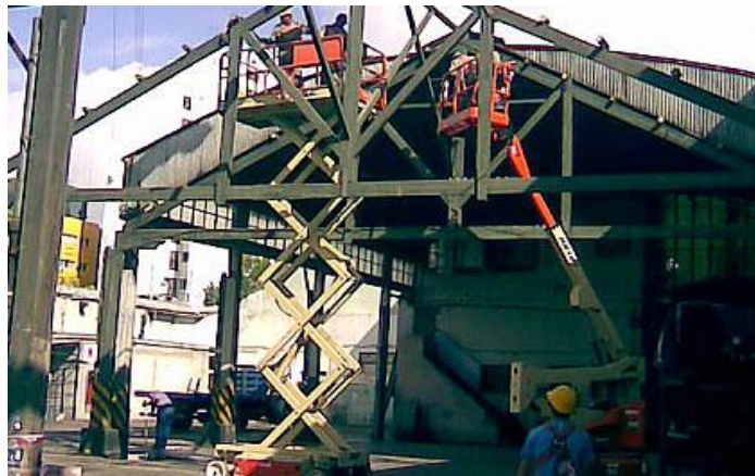
Fig. 17. Acero de Naves Industriales.
