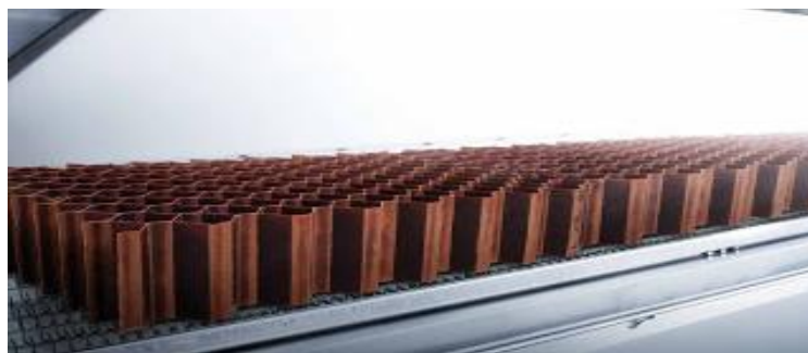
Fig. 39 Estructura de los Muros de la Casa de Papel.
