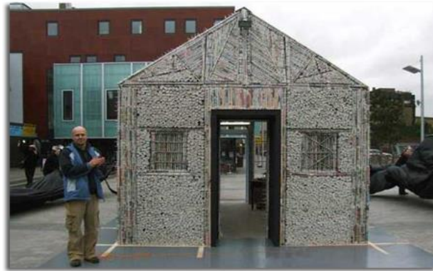
Fig. 43. Casa Construida con Bloques de Papel
