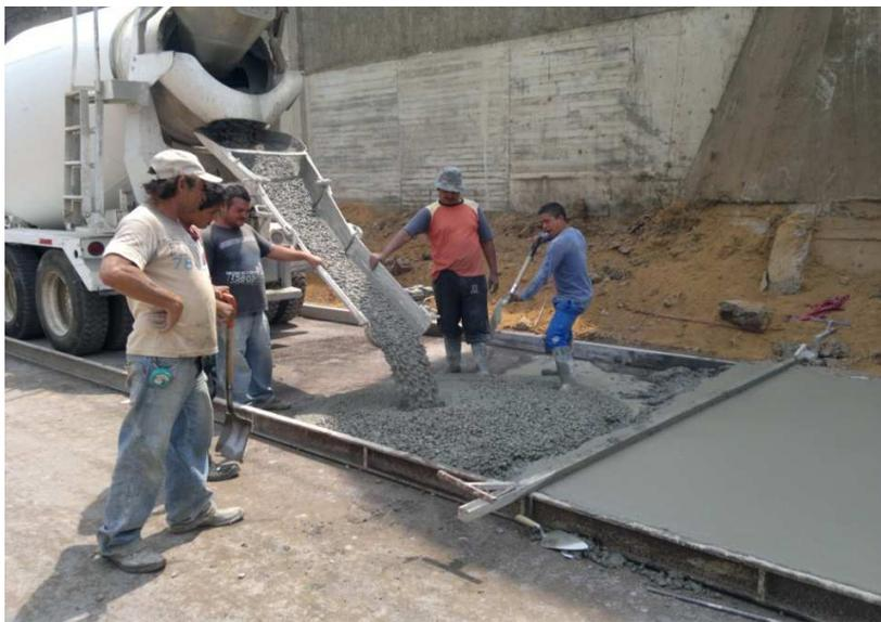
Imagen 17.- Acomodo de concreto para poder realizar el acabado en la superficie.
