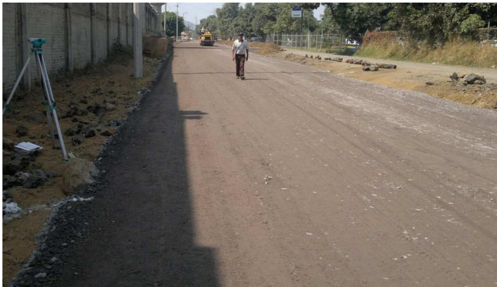
Imagen 10.- Compactación del material de base con rodillo vibratorio.
