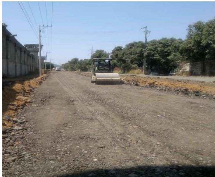
Imagen 7.- Compactación del material de sub-base, con rodillo vibratorio.
