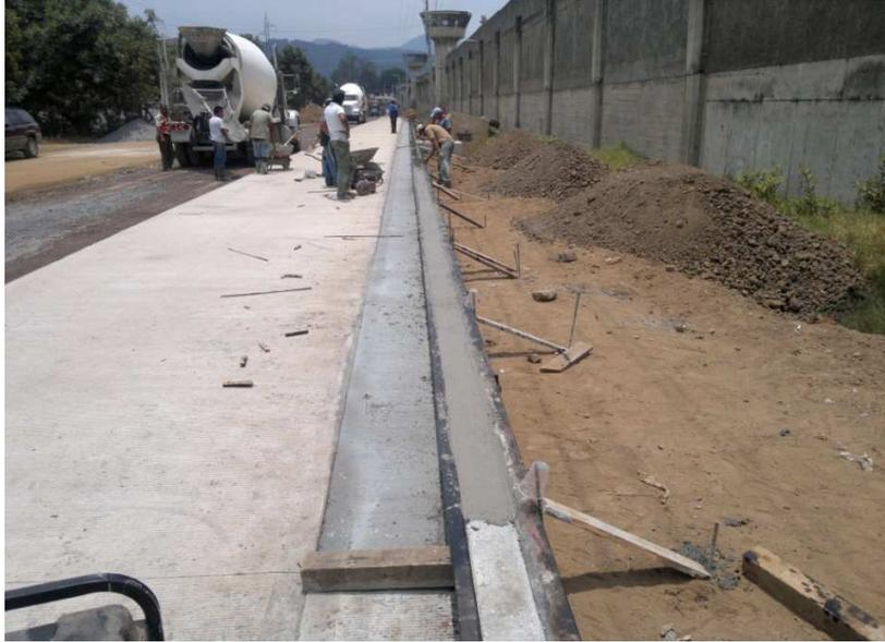
Imagen 20.- Cimbrado y elaboración de guarnición.
