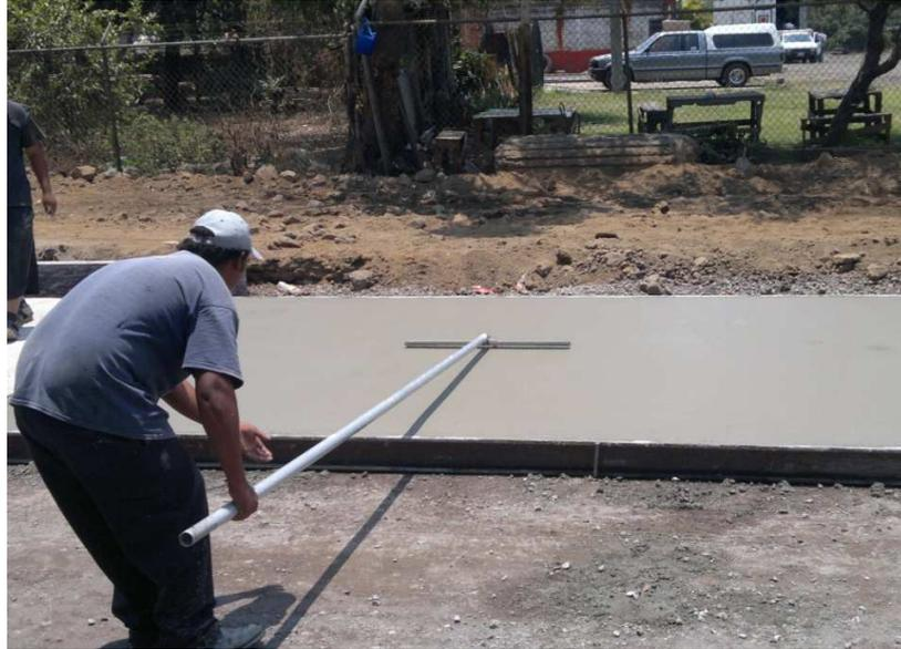
Imagen 18.- Texturizado de la superficie de rodamiento empleando un peine metálico.
