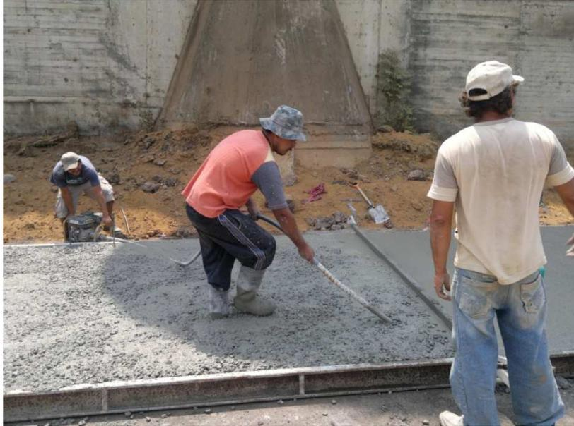
Imagen 16.- Vibrado de concreto para evitar la presencia de oquedades.
