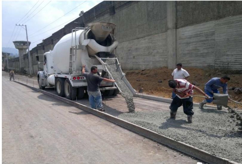
Imagen 12.- Colocación y tendido de concreto para la superficie de rodamiento.
