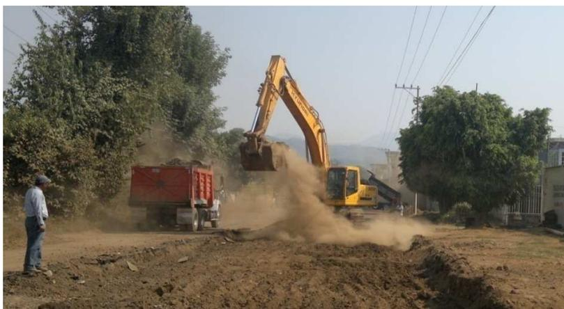
Imagen 2.- Movimiento del material producto de excavación en la zona donde se desplantará la estructura del pavimento.
