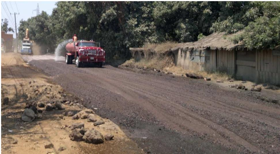
Imagen 9.- Tendido del material de base hidráulica agregándole humedad para poder lograr el grado de compactación requerido.
