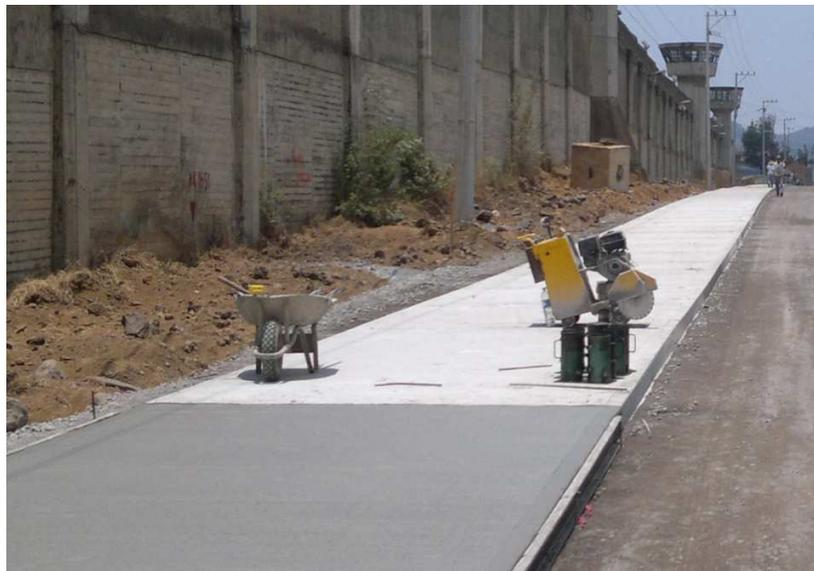
Imagen 19.- Elaboración de juntas en la superficie de rodamiento, empleado cortadora eléctrica con discos punta de diamante.
