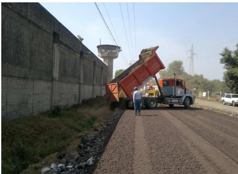
Imagen 3.- Acarreo del material producto de la excavación fuera de la obra.
